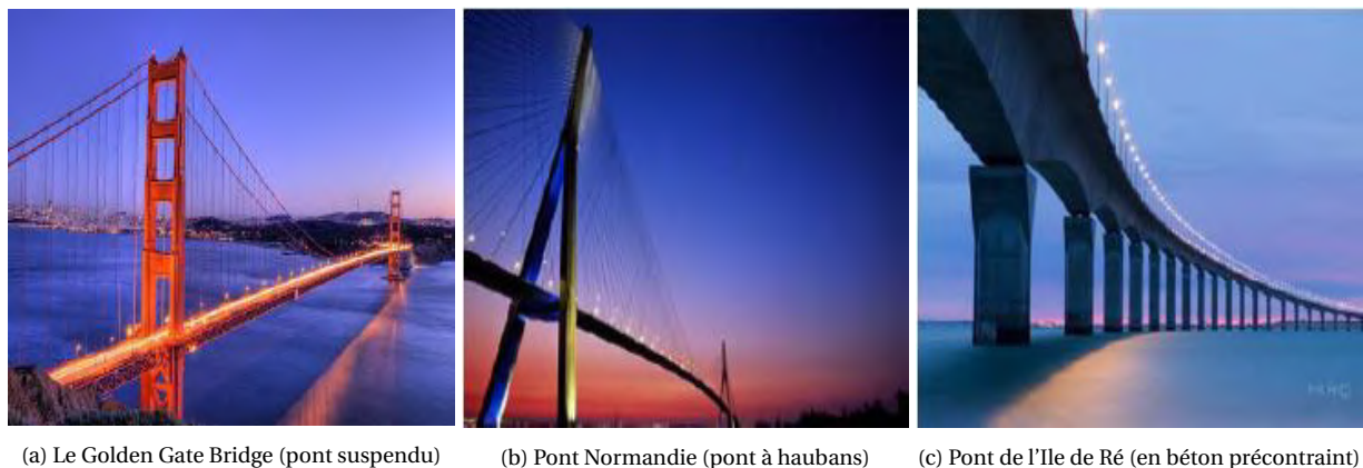
FIGURE 1.3 – Différents types de ponts en génie civil [11]
