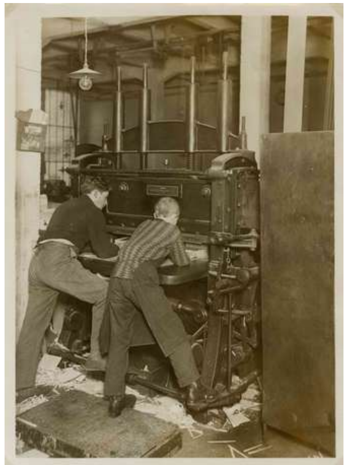
6. Deux ouvriers actionnent une rogneuse « Krause »
