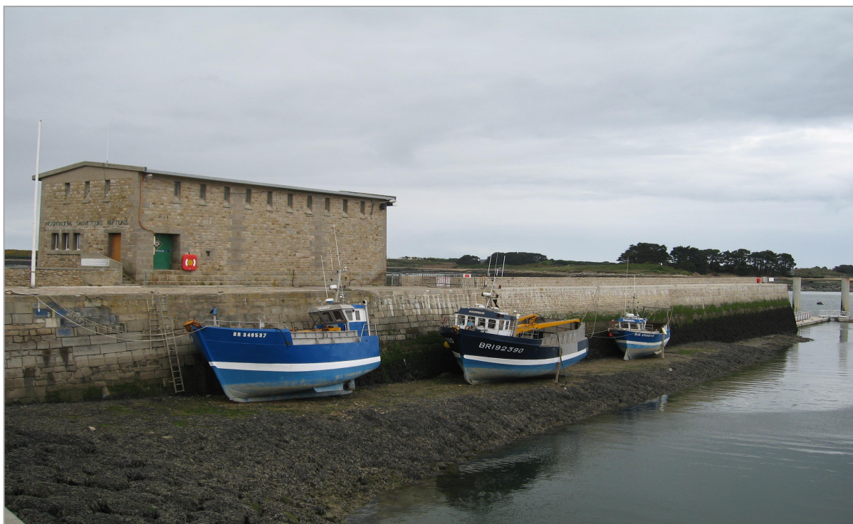
Figure 60: Abri du canot de sauvetage de l'Aber Wrac'h. Crédit Photo : OPMC 2014.
