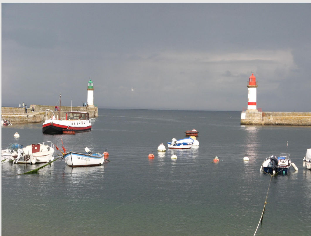
Figure 93 : Les digues de protection du port de l'île de Groix (56)
