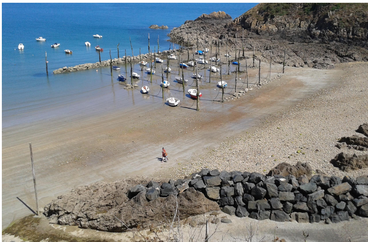
Figure 106: Le port de Gwin Zegal et son système d'amarrage sur pieux (en tronc de chêne). Plouha (22). Crédit photo : OMPC 2017
