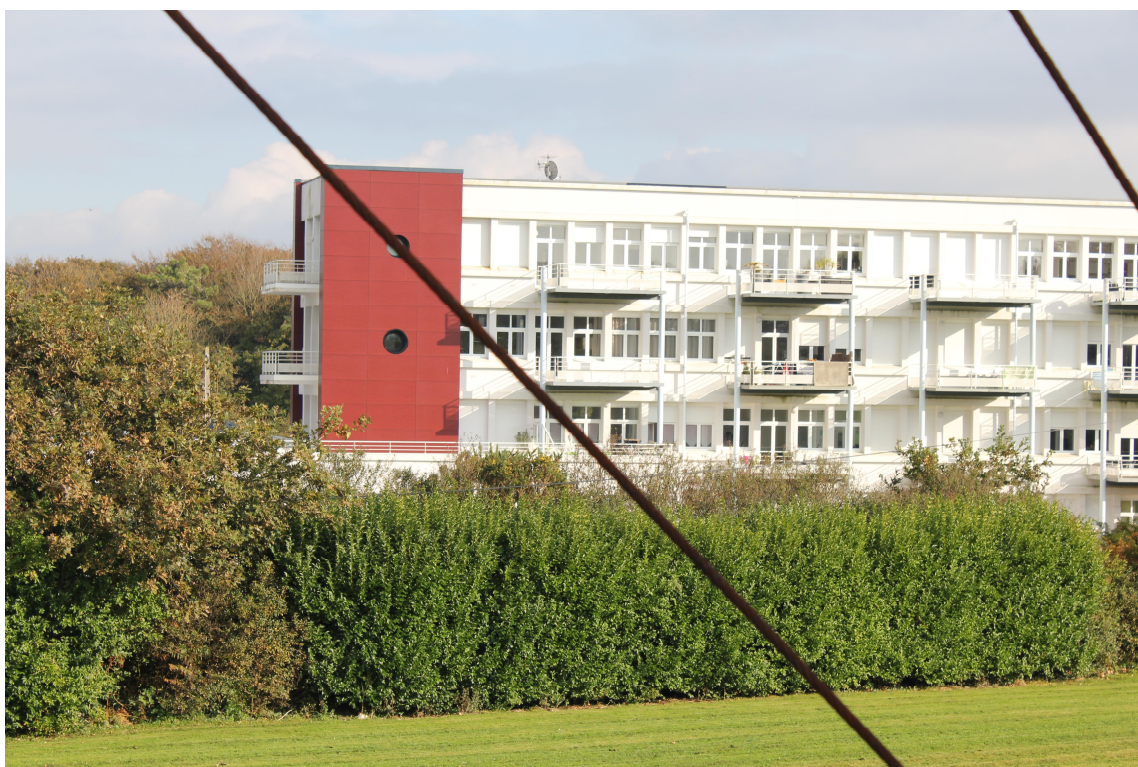
Figure 149: Photos de l'ancienne Ecole d'Apprentissage Maritime de Landéda transformé en résidence. Crédit photo: André Saunier 2012 et Laure Ozenfant 2014.
