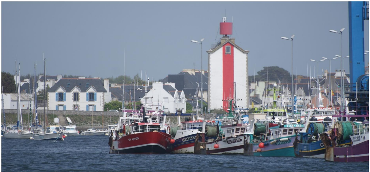
Figure 82: Le feu de Croas Malo aujourd'hui surmonté d'une boule et peint d'une bande rouge verticale en façade. Été 2016. Crédit photo: OPMC.
