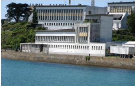
L'ancien bâtiment de l'Ecole d'Apprentissage Maritime en cours de réhabilitation pour accueillir des appartements et le musée maritime.
