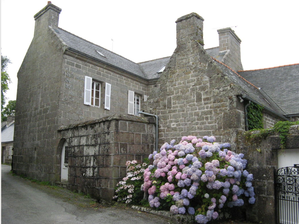
Figure 91 : La maison située au n°7, rue Rumorvan à Lanildut. Crédit photo : OPMC 2013.
