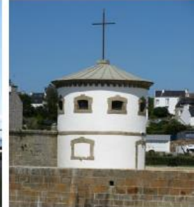
Un bâtiment emblématique de surveillance des côtes à réinsérer dans le site actuel.
