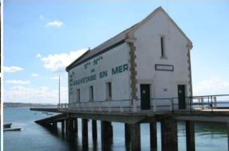
L'ancien abri du canot de sauvetage : un bâtiment à recycler pour être un lieu d'accueil et de mémoire.
