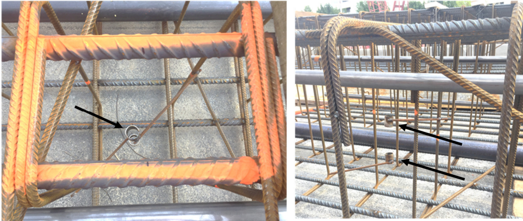
Figure II-112 Les barres de fixation alignées pour que le capteur soit installé horizontalement
