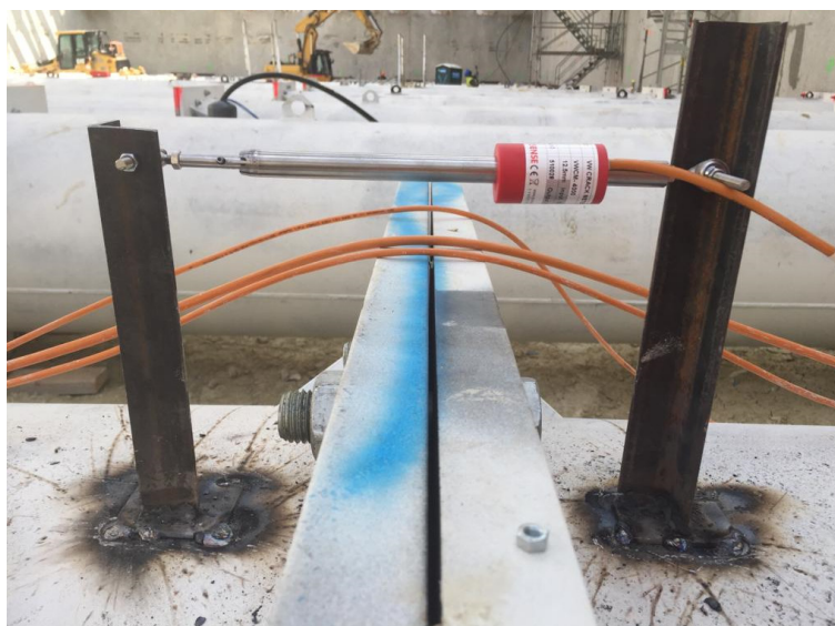
Figure II-128 : Photo de l'installation du fissuromètre en tête sur l'assemblage entre deux platines du B3-19
