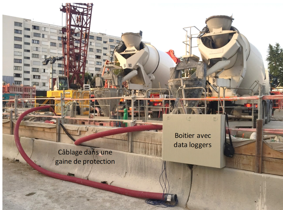
Figure II-115 Le boîtier avec les data loggers des CP lors du bétonnage du panneau
