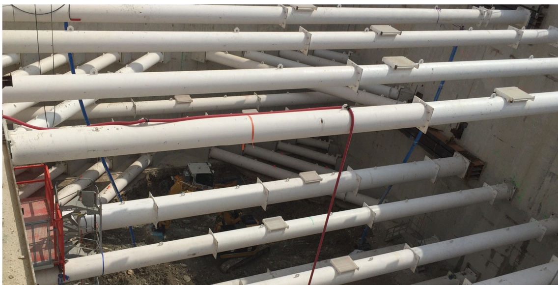
Figure II-21 : Vue de la fouille des Ardoines butonnée
