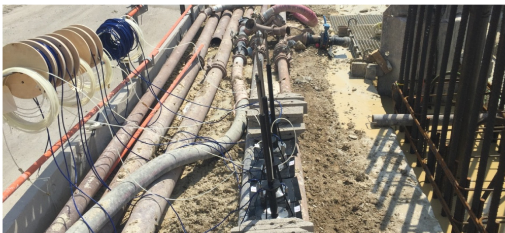
Figure II-113 Mise en place des bobines sur une barre pour un déroulage efficace des câbles
