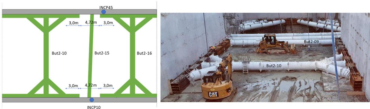
Figure II-65 : Vue en plan détaillée de la Boîte Centrale au 2<sup>e</sup> niveau de butons avec une photo du chantier
