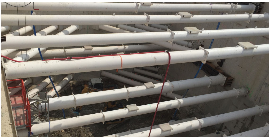
Figure II-21 : Vue de la fouille des Ardoines butonnée
