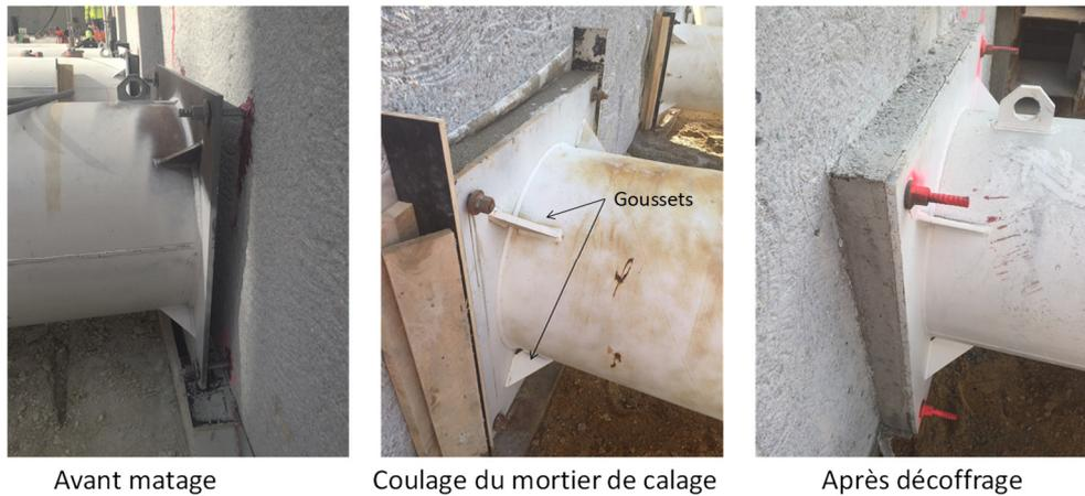
Figure II-24 : Matage – technologie d’assemblage de la platine du buton contre la paroi moulée
