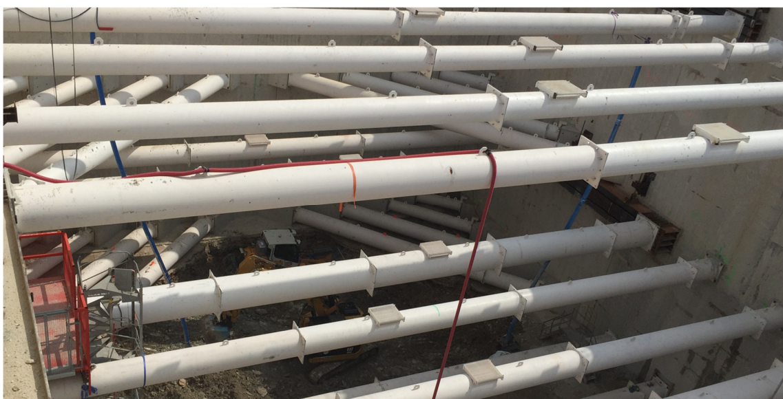
Figure II-21 : Vue de la fouille des Ardoines butonnée
