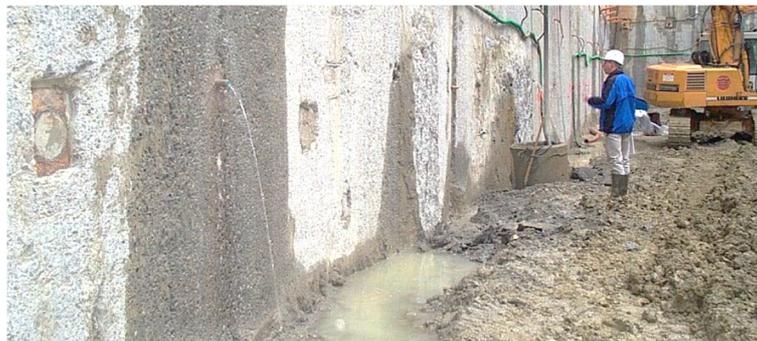
Figure I-17 Drainage à l'arrière de la paroi sur le chantier du Canal du Midi
