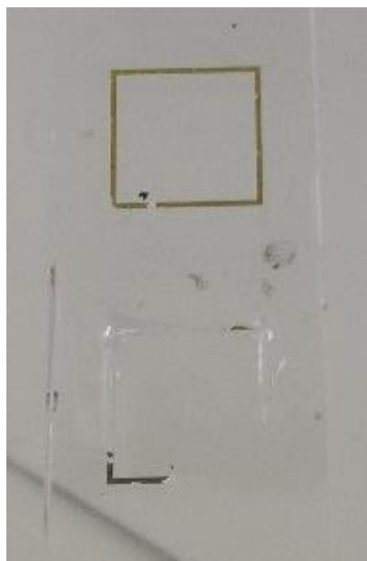
Figure 2-21 : arrachage du verre en périphérie du cordon de soudure.
