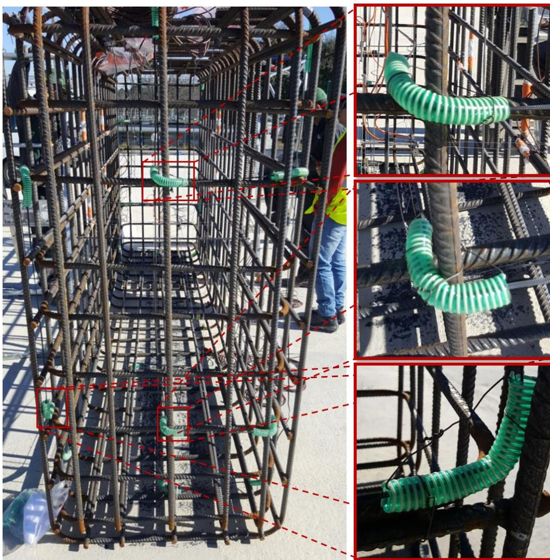
Figure IV-20 : Instrumentation du Bloc KB par câble Neubrex noyé dans le béton.
