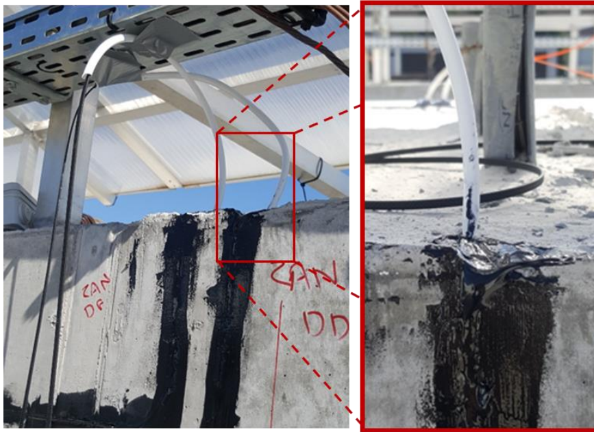
Figure IV-22 : Protection des sorties du câble Neubrex collé en surface du Bloc ZA à l'aide de gaines en PVC.
