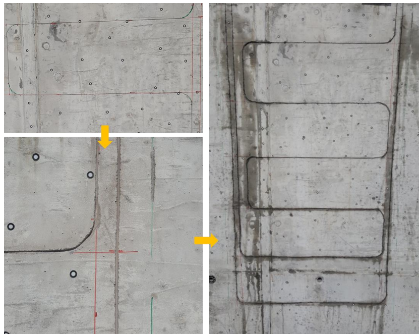
Figure IV-13 : Instrumentation en surface du Bloc ZA avec le câble AFL : parcours tracé, rainuré puis nettoyé.
