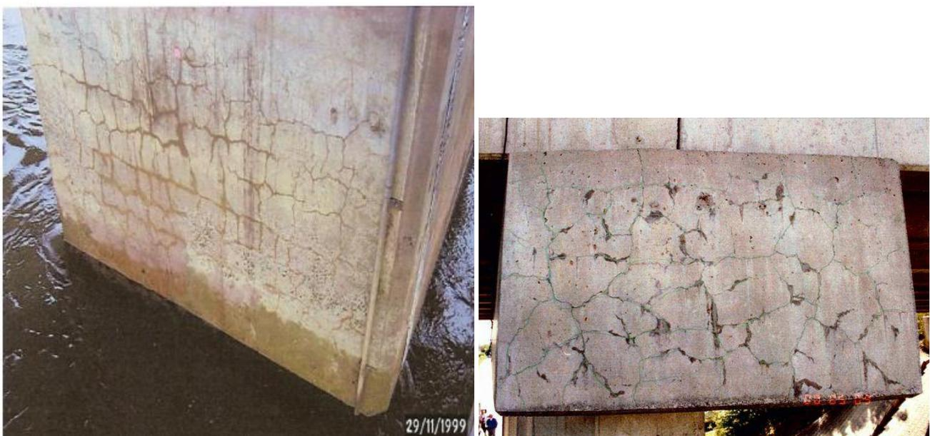
Figure I-47 : Manifestations de la RSI (réseau de fissures) [110].
