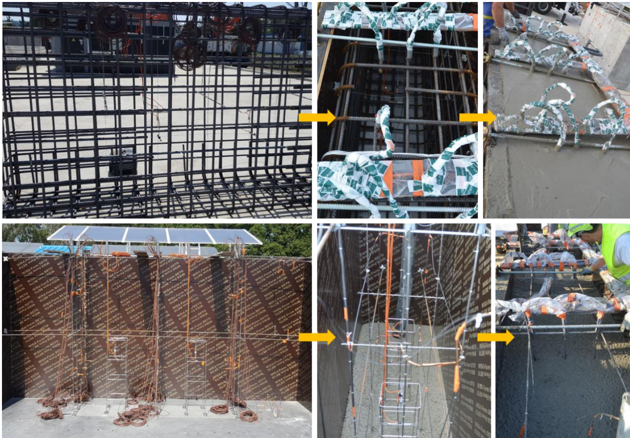
Figure IV-5 : Phases de fabrication de deux blocs : bloc EB armé (trois photos du haut) et Bloc IB non armé (trois photos du bas).
