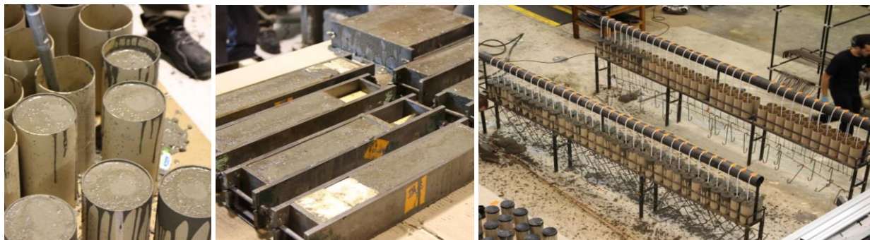
Figure II-12 : Photographies prises lors du premier coulage du béton ZA (30 août 2018).
