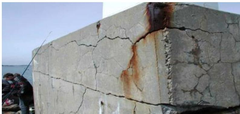
Figure I-49 : Béton affecté par la RAG [114].
