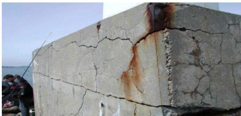
Figure I-49 : Béton affecté par la RAG [114].
