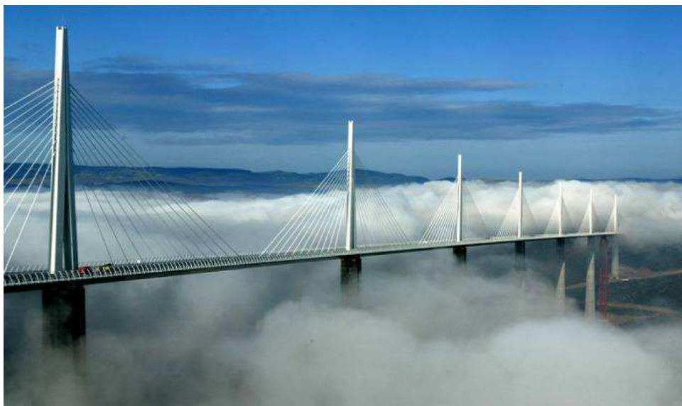
Figure I-1 : Viaduc de Millau (instrumenté à l'aide de différents capteurs durant la phase de construction, le lancement du tablier et la phase d'exploitation) [3].
