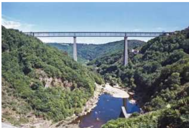
Figure 20 Le viaduc des Fades.
