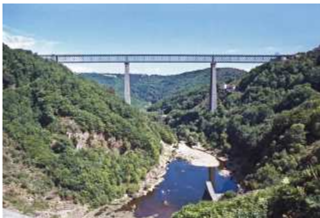
Figure 20 Le viaduc des Fades.
