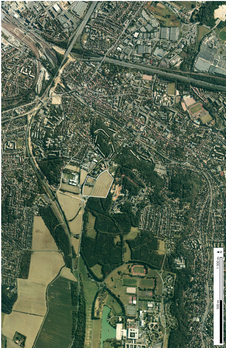
Figure 15 – Le site du projet Quartier Camille Claudel, en bordure du plateau de Saclay, entre le campus de l'École Polytechnique et la vallée, 2011 Source : Google Earth
