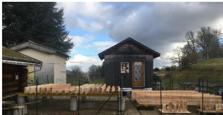
Figure III-3 : Poutres CND dans la zone expérimentale extérieure
