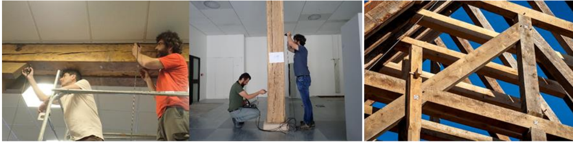
Parc du Pont de Flandre (2021) Maquette charpente Notre Dame à Felletin (2021) Figure 4 : Mise en application du Contrôle Non Destructif structurel
