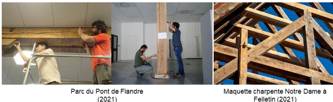
Figure 4 : Mise en application du Contrôle Non Destructif structurel
