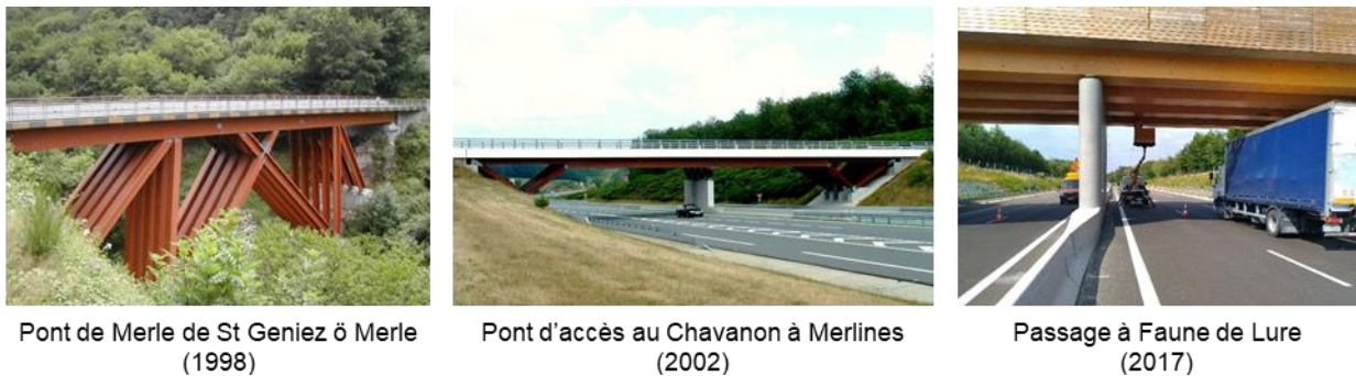
Figure 3 : Développement du monitoring hydrique sur ouvrages d'art
