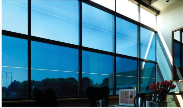
Figure I.2: Illustration d'un vitrage électrochrome. La partie basse est colorée en bleu et bloque une partie de la lumière visible-IR alors que la partie haute est transparente ce qui permet de laisser passer une grande partie de la lumière au moins dans le visible [9].
