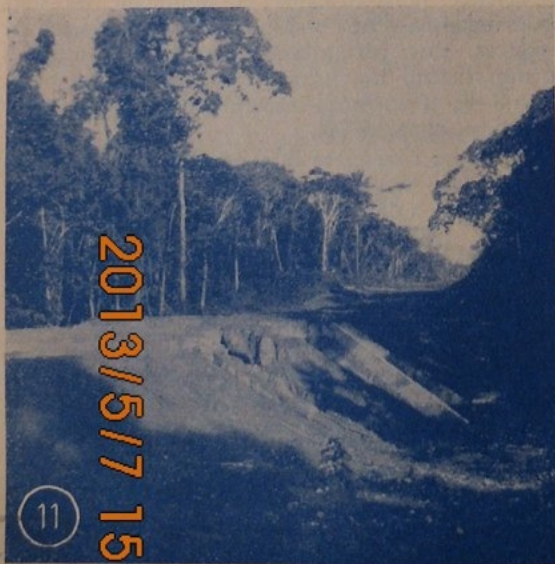
Cl. n° 11 et 12. Plate-forme profondément ravinée par plusieurs tornades quelques jours après sa construction. Le réglage de la plate-forme était insuffisant : profil « en fond de bateau » ; fossés non faits.
