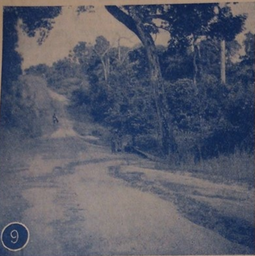
Cl. n° 9. Ravines longitudinales. Piste en argile latéritique. Oubangui. — Cl. n° 10. Ravines transversales sur l'accotement d'un macadam bitumé (Côte d'Ivoire).
