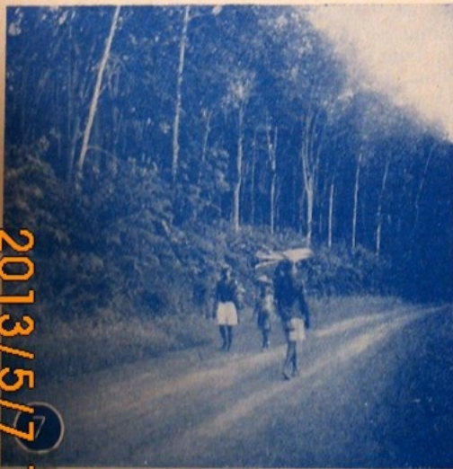
Cl. n° 7. Cameroun : Piste Douala-Edéa dans la plantation d'hévéas de la Dizangué. Bonne latérite argileuse; plate-forme trop étroite. Cl. n° 8. Togo. Entretien d'une piste en sable argileux latéritique. Rechargement d'ornières « au petit panier ».
