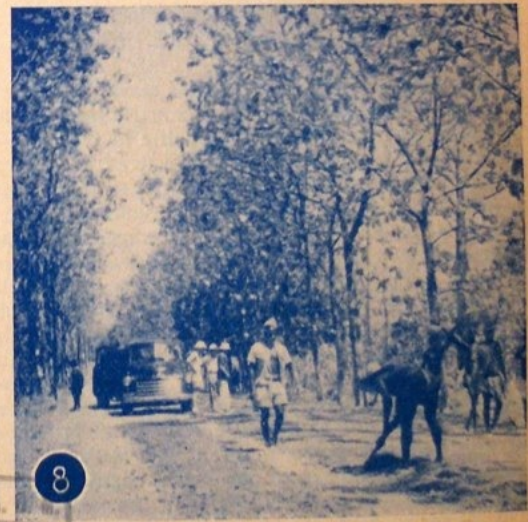
Cl. n° 7. Cameroun : Piste Douala-Edéa dans la plantation d'hévéas de la Dizangué. Bonne latérite argileuse; plate-forme trop étroite. Cl. n° 8. Togo. Entretien d'une piste en sable argileux latéritique. Rechargement d'ornières « au petit panier ».
