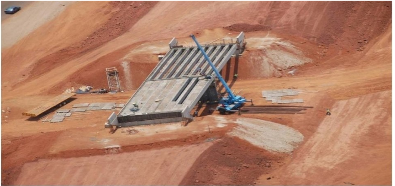
Pose des prédalles au PS 20.2
