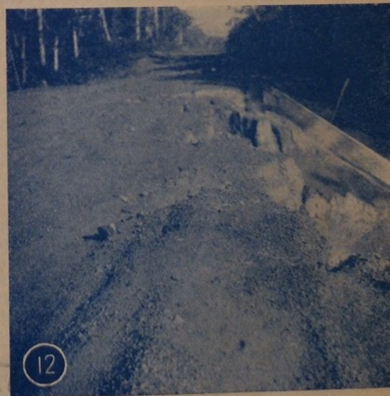
Cl. n° 11 et 12. Plate-forme profondément ravinée par plusieurs tornades quelques jours après sa construction. Le réglage de la plate-forme était insuffisant : profil « en fond de bateau » ; fossés non faits.
