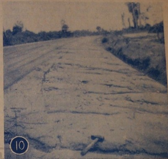
Cl. n° 9. Ravines longitudinales. Piste en argile latéritique. Oubangui. — Cl. n° 10. Ravines transversales sur l'accotement d'un macadam bitumé (Côte d'Ivoire).
