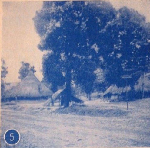
Cl. n° 5. Sénégal. Bonne plate-forme en terre à Bambeï. Couche d'amélioration en latérite, avec « tôle ondulée ». Cl. n° 6. — Niger. 30 kilomètres Est de Dosso. Assez bonne piste trop étroite, en sable argileux.
