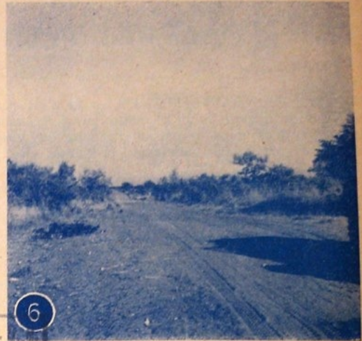
Cl. n° 5. Sénégal. Bonne plate-forme en terre à Bambeï. Couche d'amélioration en latérite, avec « tôle ondulée ». Cl. n° 6. — Niger. 30 kilomètres Est de Dosso. Assez bonne piste trop étroite, en sable argileux.
