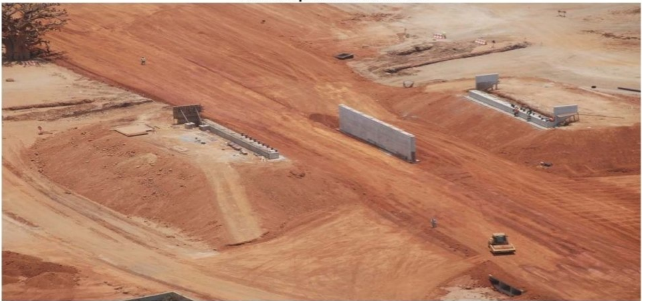
Pile au PS 16.2
