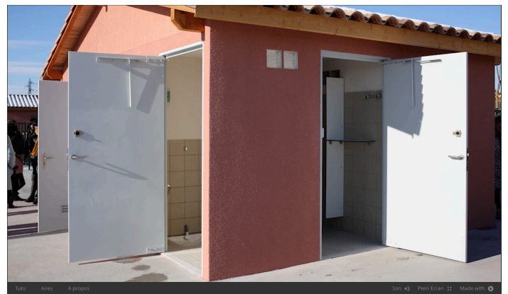
Photo 71 : Visite des blocs sanitaires
