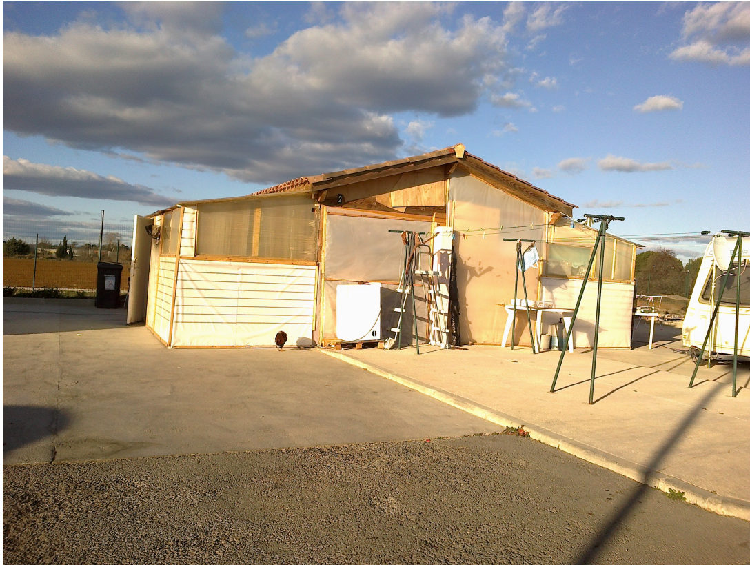
Photo 77 : Construction temporaire à partir du bloc sanitaire, aire de Lunel, collection personnelle, 2012.
