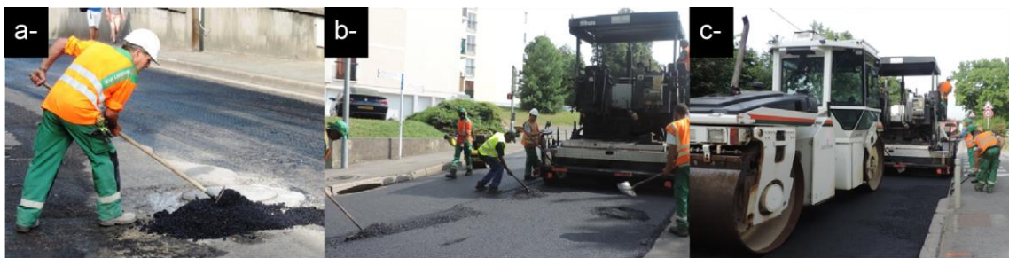
Figure 10-10 – Application d'un revêtement bitumineux
