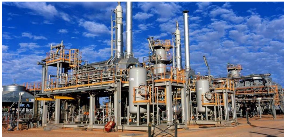
Figure 10 : Unité de capture du CO 2 utilisant les amines pour purifier le gaz naturel (usine BP d'In Salah en Algérie) 42
