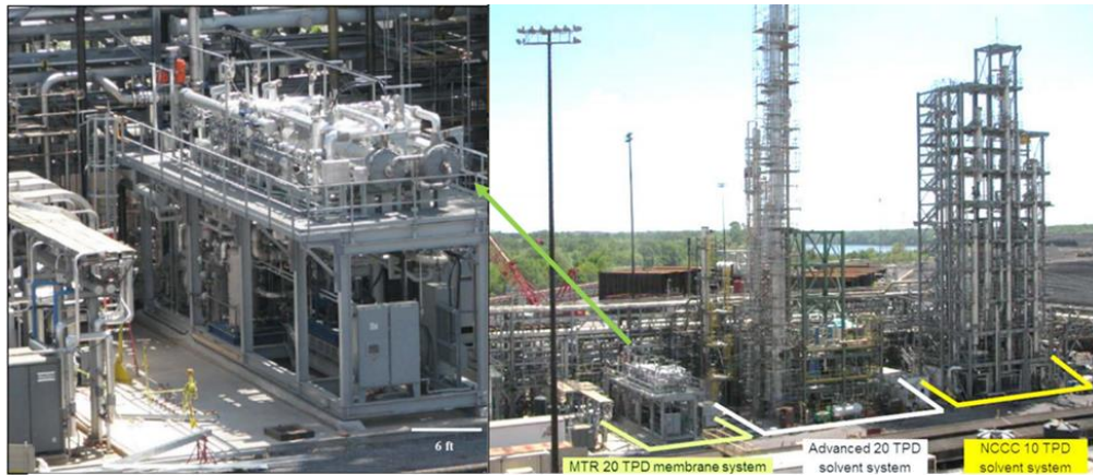
Figure 14 : Projet MTR 20 tCO 2 /j (MTR 20 TPD, en vert) comparé à deux unités utilisant des amines (en blanc, et en jaune) 75
