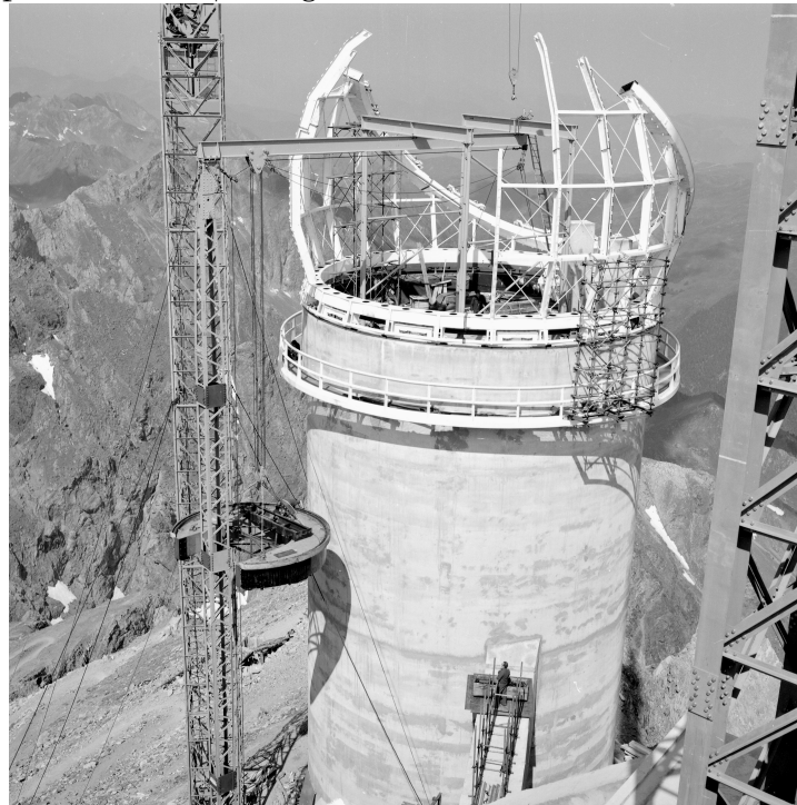
Figure 2.13 – Construction de la coupole du Télescope Bernard Lyot (probablement en 1971). | © Régie du Pic du Midi
