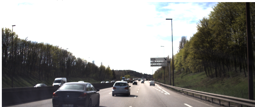
(b) Une image prise sur le tronçon d'autoroute.
