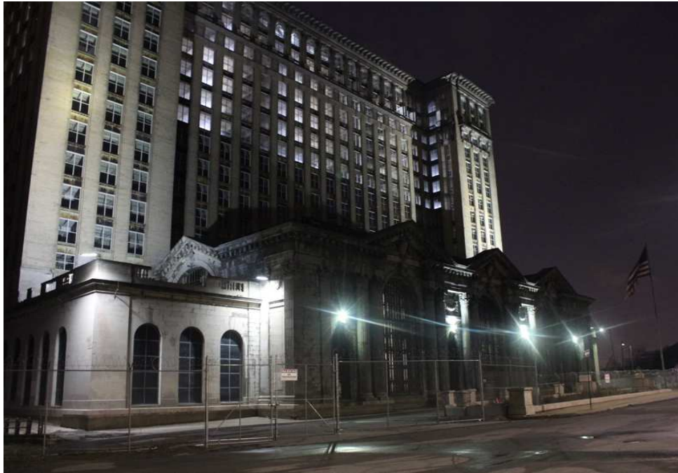
Michigan Central Station , Détroit, avril 2016. Collection de l'auteur.
