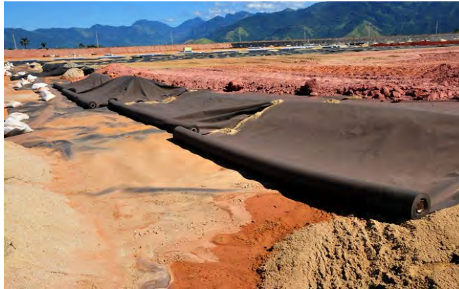
Figure 73 : Les couvertures d'imperméabilisation installées dans le chantier de la CTR Rio.
