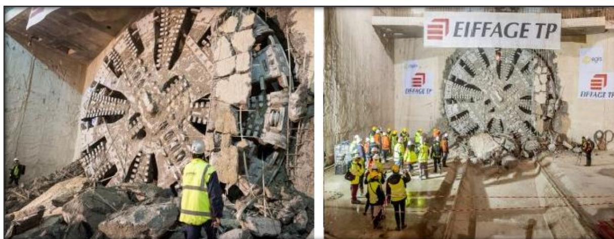
Figure 5-2 : Le tunnelier Nolwenn utilisé pour le creusement du tunnel du tramway T6
