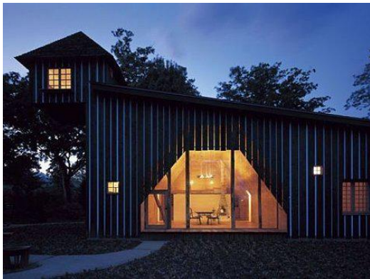
79. Les bandes verticales espacées, Fujimori Terunobu, Yakisugi House - Maison de Cèdre Carbonisée , Nagano, 2007, Michael Buhns et Hannes Rössler, Fujimori Terunobu , Architect Villastuck , Éditions Hatje Cantz, Munich, 2012.
