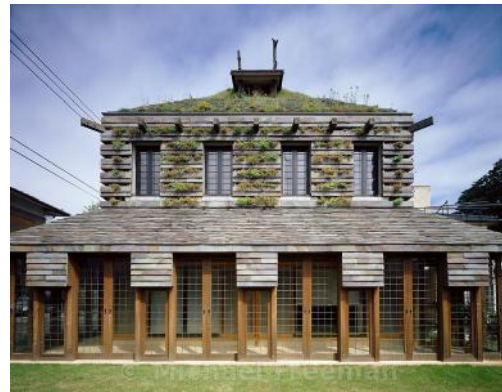
80. Les bandes horizontales espacées de pissenlits, Tanpopo House - Maison de Pissenlit , Kokubunji, Tōkyō, 1994-1995, © Michael Freeman.
