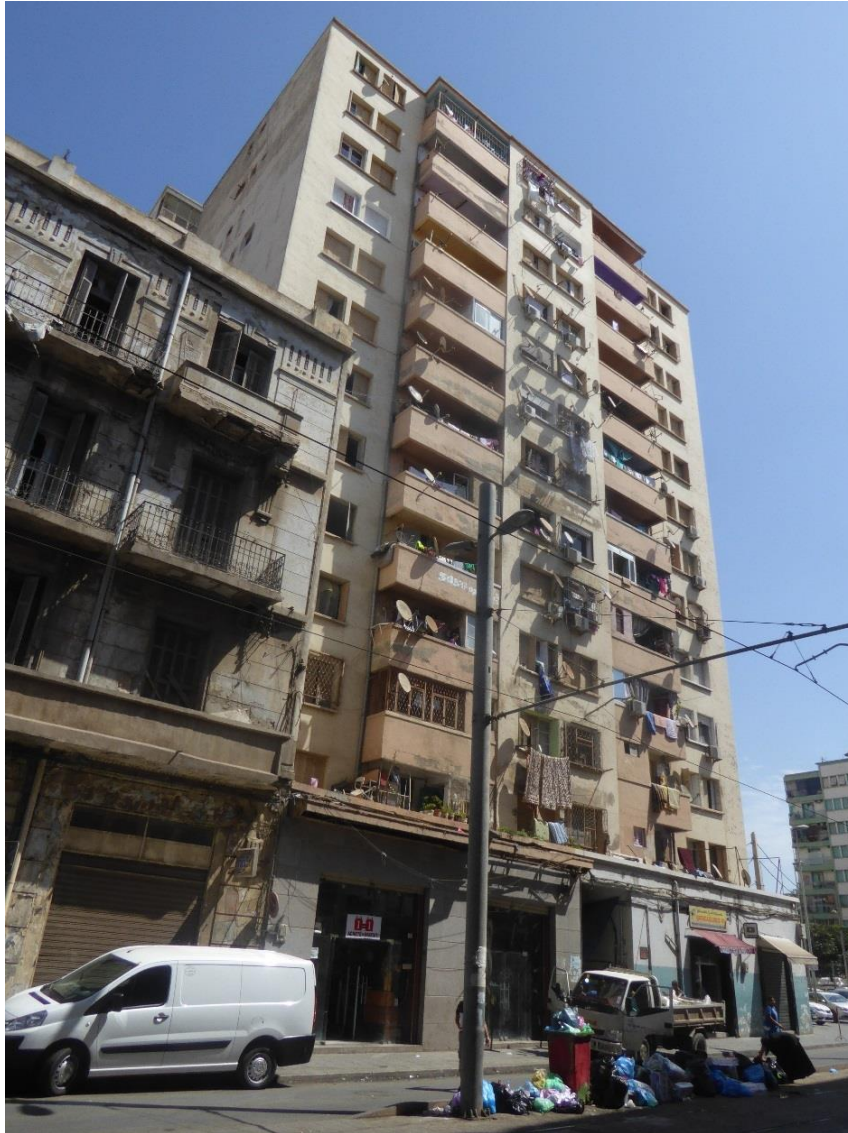
Photo n°6, une des entrées de la cité Perret, septembre 2017.
