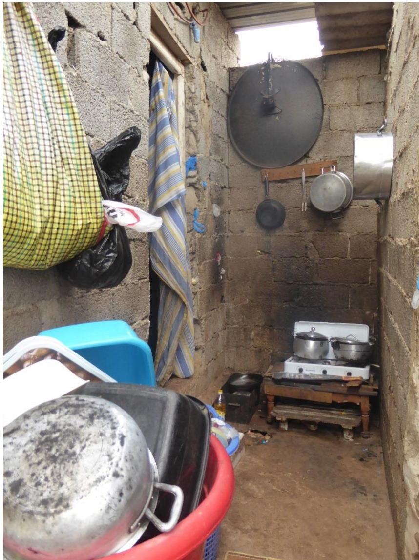
Photo n°7, maisonnette dans le quartier des Amandiers, septembre 2017. Cuisine en semi-extérieur, sol en terre battue, murs en parpaings apparents, toit en tôle.
