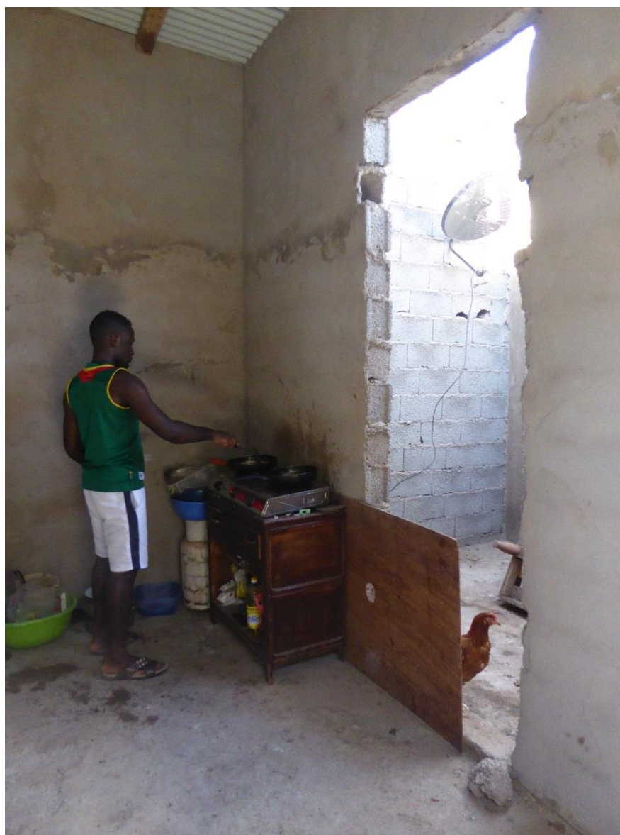
Photo n°14, maisonnette dans le quartier d'Aïn Beïdha, août 2017. Cuisine en semi-extérieur (ouverte sur le couloir extérieur et le poulailler). Coin poulailler. Murs en parpaings, toit en tôle.
