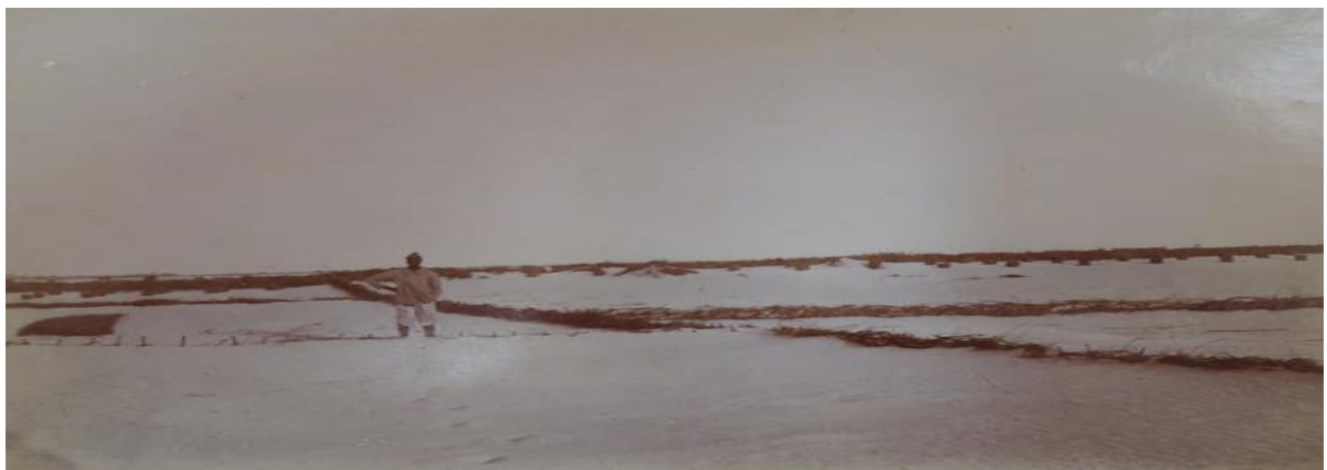
Figure 11 Commencement d'engraissement de la Langue de Barbarie par Clayonnages, photo : colonie du Sénégal, travaux publics, 1929.
