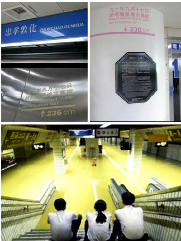
Figure 5-3-04 Inondations du métro et des rues lors du passage du typhon Nari en 2001.
