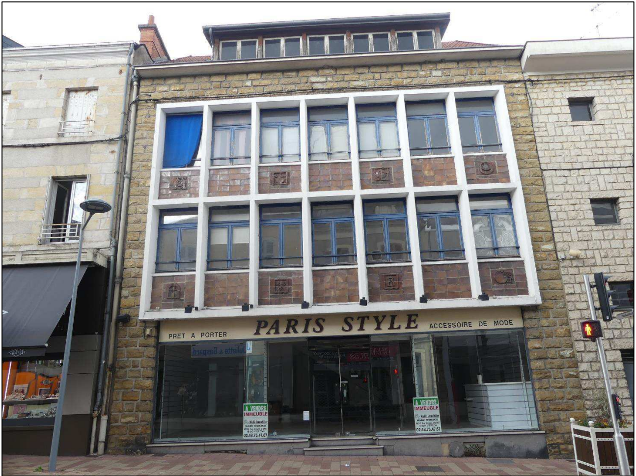
Figure 41 : un immeuble entier à vendre à Vierzon (Cuenot, 2019)
