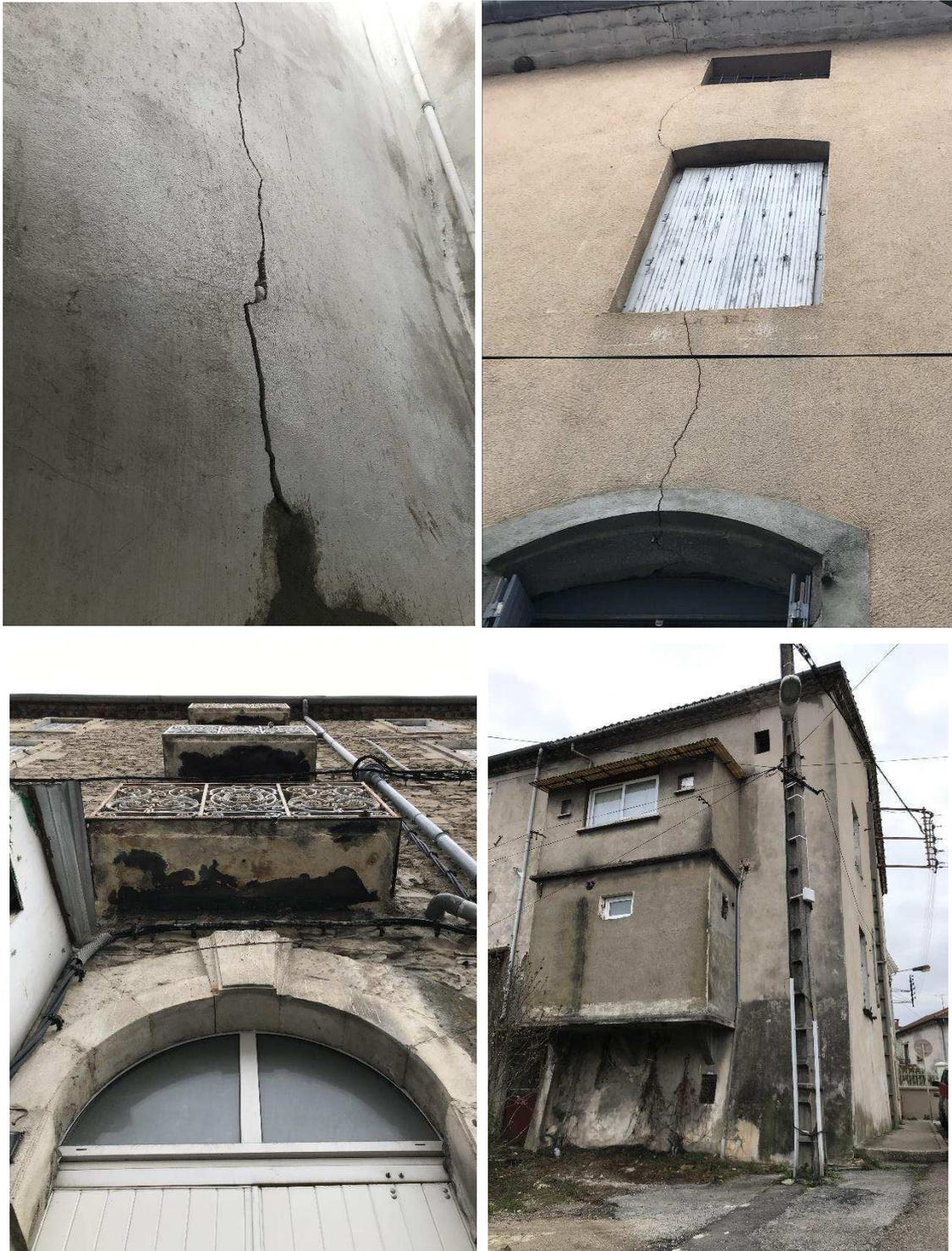
*Figure 84 : d'autres sont très dégradés : ils peuvent mettre en danger les occupants et conduire à du mal-logement (Anduze et La Grand'Combe) (Cuenot, 2020)*
