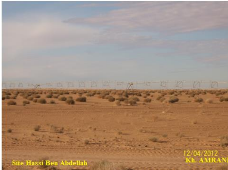
Photo 26 : Rampe pivot abandonnée
