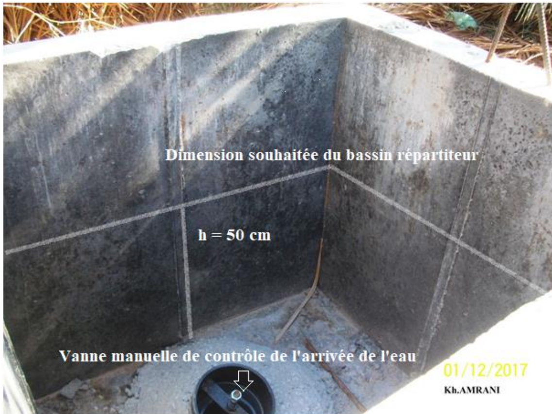
Photo 27 : Résultats des travaux de réfection confiés aux entrepreneurs
