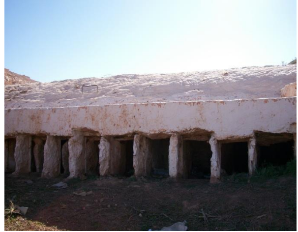
Photo 3 : répartition de l'eau
