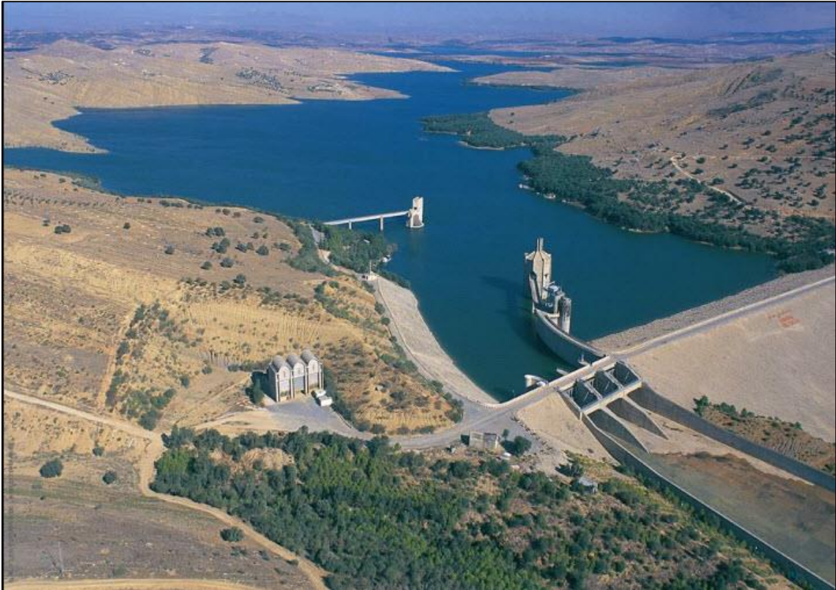
Photo 9 (A sur fig. 5). Vue sur la retenue de Sidi-Selem, immédiatement en aval de sa digue (photo : Ministère de l'Agriculture, 2015).
