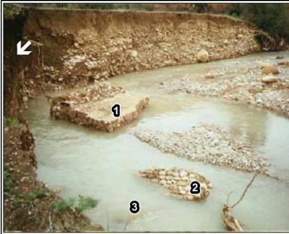
Photo 56. Photo prise par Mjejri en 2006 sur l'oued El-Hammem, révélant des « pans de murs antiques basculés » dans le chenal d'écoulement (Cl., Mjejri, 2006).
