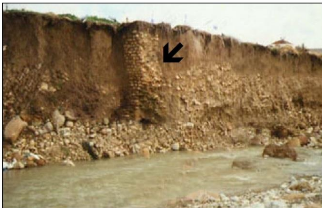
Photo 53. Photo prise en 2006 en face de la berge gauche de l'oued El-Hammem, montrant les fondements d'une ancienne construction exhumée par l'action érosive des eaux de crue (Cl., M. Mjejri, 2006).
