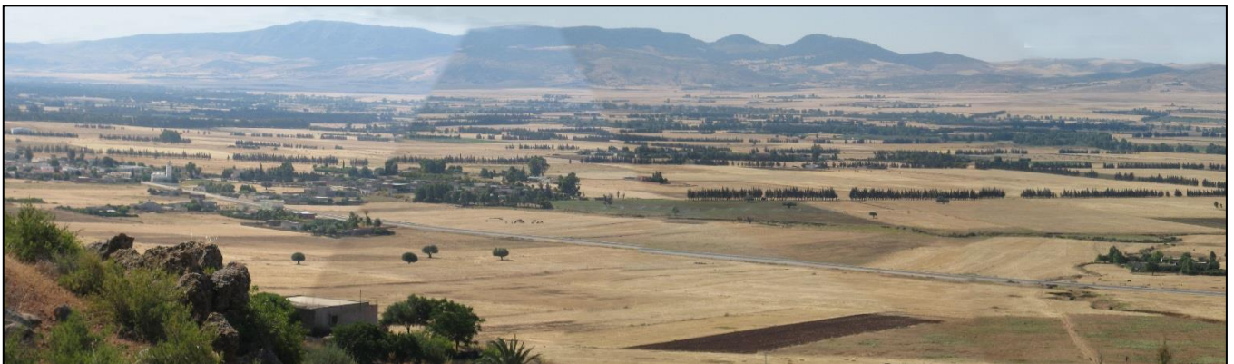
Photo 2 (B sur fig. 3). Une vue de versant à versant à travers la vallée de la Medjerda à Ghardimaou, prise depuis le versant sud de Jbel El'Hafer à Kef Edhba'a à 1,5 km de douar Edkhailiya (x : 455468 ; y : 4041466 ; photo : L. Lahmar, 23/6/2009).
