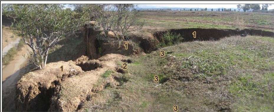
Photo 15. Systèmes de trous de suffosion dont certains ont déjà donné naissance à des cicatrices d'arrachement de pans et au ravinement (1). D'autres sont en cours d'évolution préparant l'ouverture de fentes de dessiccation (2). Le reste est encore inopérant mais ne tarde pas longtemps à fonctionner pareillement (3). Vue sur la berge droite de la Medjerda, 700 m en amont de Sidi-Meskine à Jendouba (Cl., personnel, 30/11/2013).
