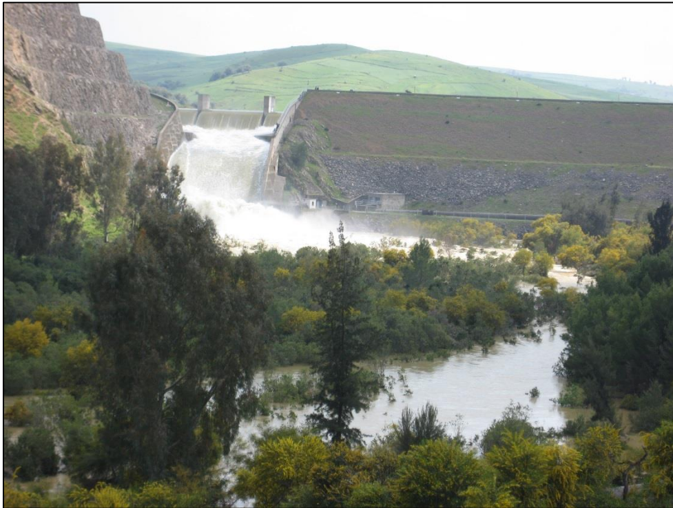
Photo 26. La retenue du barrage de Bou-Hertma étant pleine, surverse sur le seuil de surface (cliché : L. Lahmar, 23/4/2009).
