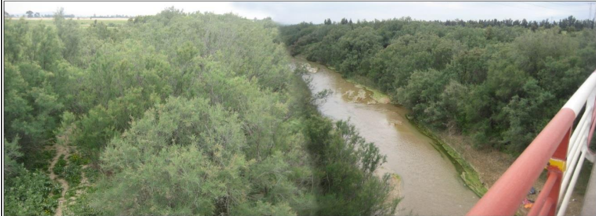
Photo 12. Cours aval de l'oued Tessa au niveau du pont-route GP5 (Cl., personnel, 24/04/2017).
