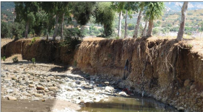
Photo 2. Déchaussement des plantations riveraines sous l'effet du retrait de la berge droite du cours aval d'El-Hammem à Werghich (Cl., personnel, 13/06/2009).
