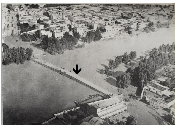
Photo 10. La crue de 1969 : des eaux coulant à pleins bords touchant la partie supérieure du pont ( archives des SNCFT, ponts et chaussées, 1969).
