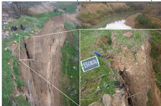
Photo 10. Fentes de cisaillement visibles sur la berge droite de l'oued Medjerda, 1,7 km en amont de la ville de Testour (Cl., personnel, 13/01/2014).
