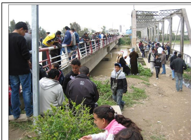
Photo 14. Une foule de riverains suivait les progrès de la crue au droit du pont-route GP6. À un certain niveau critique repéré par eux-mêmes sur les piliers, ils savaient d'avance que le débordement aurait lieu (Cl., personnel, 23/04/2009).
