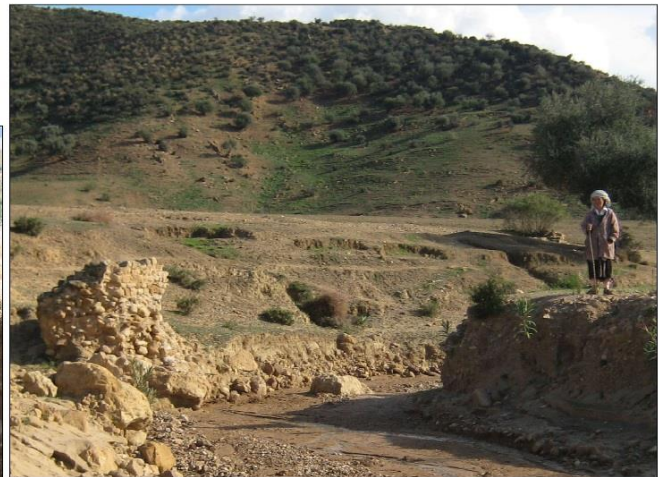
Photo 3. Ruines antiques défoncées par les eaux de l'oued Bou-Sbi'a, affluent du cours aval de l'oued Meliz (Cl., personnel, 08/11/2008).
