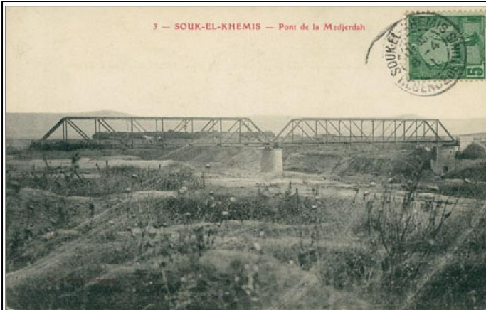
Photo 32. Carte postale, datée du 08-04-191, donnant une vue orientée Nord-Sud du lit de l'oued Medjerda au droit de son pont abandonné à Souk El-Khemis, l'actuelle Bou-Selem. Noter la largeur du lit fluvial et la raideur modérée de ses berges surtout de la rive gauche (pièce trouvée sur le site internet : www.delcampe.net ).
