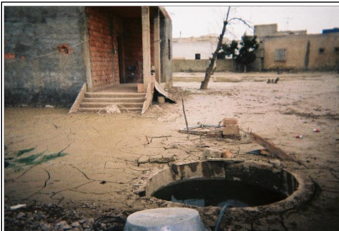
Photo 50. La cour d'une maison à Bou-Selem comblé de matériaux terreux, provenant de l'oued Medjerda lors de sa crue en janvier 2004 (Cl., personnel, 05/03/2004).
