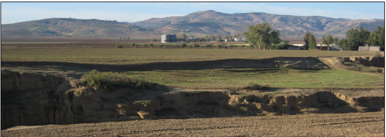
Photo 1 (A sur fig. 3). Vue depuis la berge droite du cours aval de l'oued Meliz en regardant vers le relief dominant de Guern El-Khrarib et de Esra (x : 462077 ; y : 4032724). Elle montre une vaste plaine presque sans pente, mis à part des anciens talus, exploitée en céréales jusqu'aux pieds des versants ravinés où l'on reconnaît un silo à l'arrière-plan (photo : L. Lahmar, 8/11/2008).
