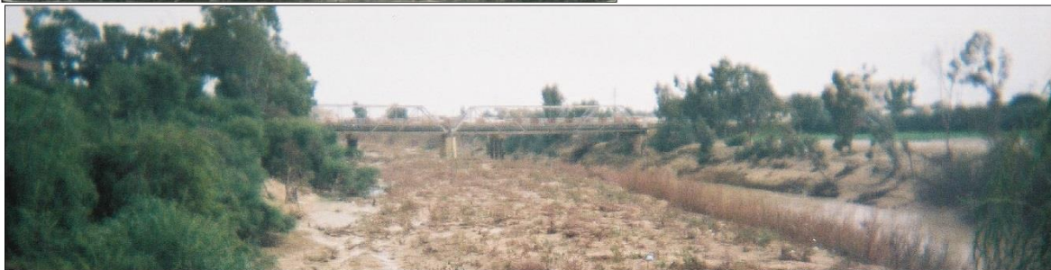
Photo 33. Photo du même lieu prise après deux mois de la crue de janvier 2004. Mise en place d'une importante accumulation de charge de fond, et rétrécissement du chenal d'écoulement des eaux (Cl., personnel, 05/03/2004).
