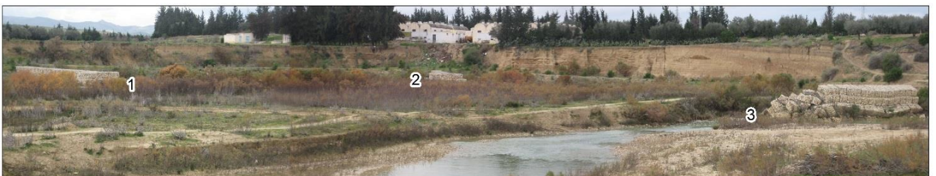
Photo 4. Trois gabions en grillages et pierres sèches hors de service suite à l'élargissement du lit de l'oued Siliana, localisé à 600 m en amont de sa confluence avec l'oued Medjerda (Cl., personnel, 12/01/2014).
