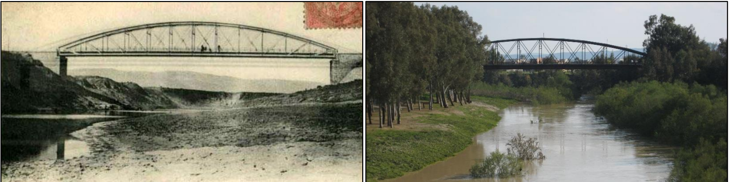
Photos 27 et 28. Deux photos prises en 1905 et en 2009, immédiatement en aval du pont de Zghaddiya à Jendouba (x : 479097 ; y : 4040204). Elles montrent que le lit moyen de la Medjerda est devenu étroit, suite à son envahissement par la végétation (cliché de gauche : trouvé sur le site internet www.delcampe.net ; cliché de droite : L. Lahmar, 14/4/2009).
