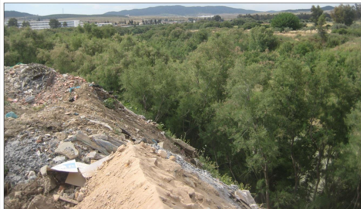
Photo 25. Le centre-ville de Mjez El-Beb, vue à l'amont du pont et en regardant vers le sud (x : 454389 ; y : 4055993). Encombrement du lit de l'oued Medjerda par la ripisylve gênant la circulation des eaux, et rejet de tas de décombres au sommet de la berge droite (Cl., personnel, 30-04-2017).
