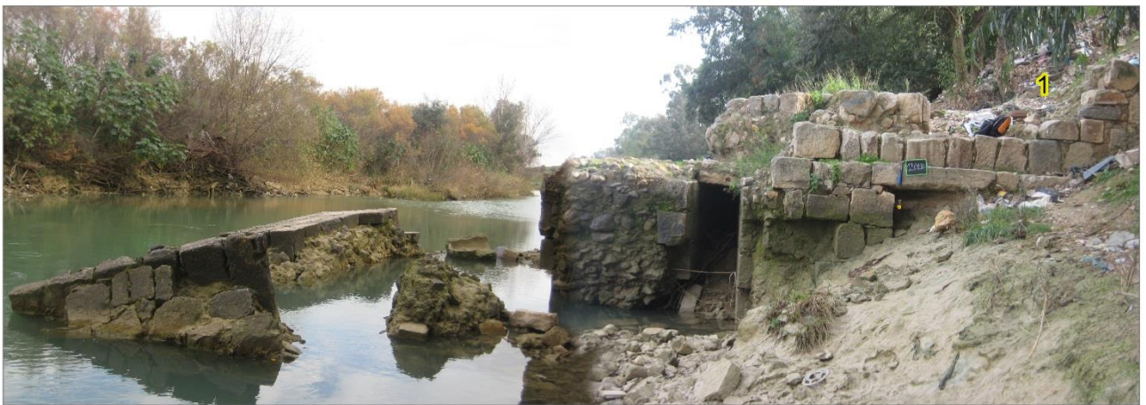
Photo 62. Les vestiges du pont et du moulin hydraulique antiques de Tichilla (Testour), localisés au pied de la berge droite de l'oued Medjerda (Cl., personnel, 12/01/2014).
