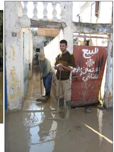
Photo 21. Des édifices à Mjez El-Beb envahis par les eaux boueuses (Cl., personnel, 03/11/2011).
