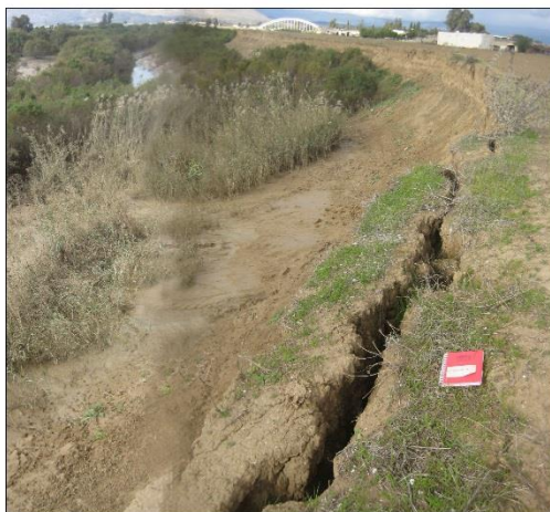
Photo 9. Rupture d'une masse terreuse le long de la berge droite de l'oued Mellègue à El-Melga, 7 km en aval de Jendouba (Cl., personnel, 30/11/2013).
