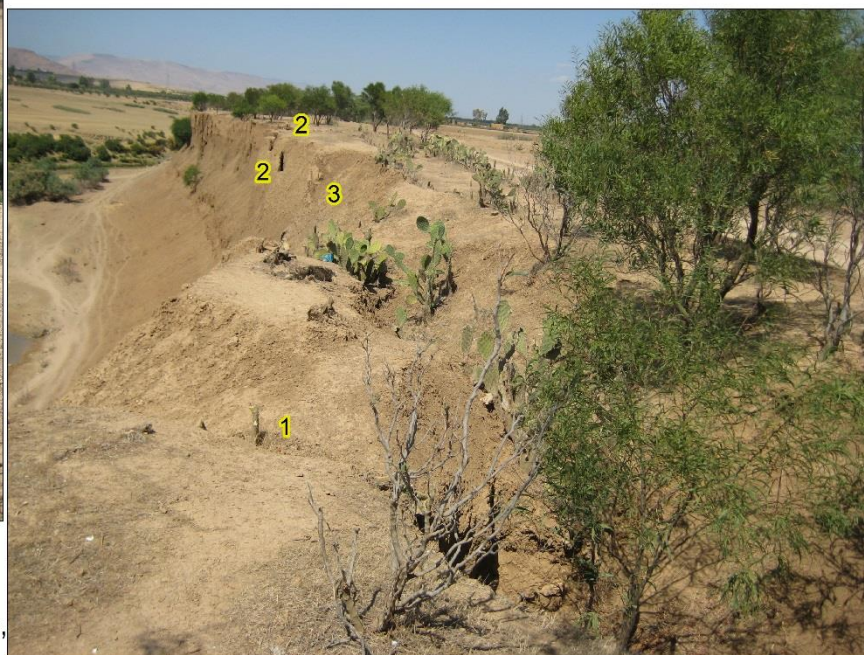
Photo 16. Formes d'érosion marquant la berge droite de la Medjerda, 5 km à l'aval de Sidi-Meskine, et travaux de lutte anti-érosive par plantation de cactus épineux (Cl., personnel, 10/08/2008). 1. Ravinement ; 2. Suffosion ; 3. Glissement
