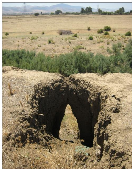
Photo 17. Trou de suffosion perçant le sommet de la berge droite de la Medjerda, 8 km à l'aval de Sidi-Meskine, et favorisant le recul d'une tête d'une ravine (Cl., personnel, 10/08/2008).
