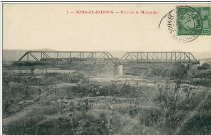
Photo 32. Carte postale, datée du 08-04-191, donnant une vue orientée Nord-Sud du lit de l'oued Medjerda au droit de son pont abandonné à Souk El-Khemis, l'actuelle Bou-Selem. Noter la largeur du lit fluvial et la raideur modérée de ses berges surtout de la rive gauche (pièce trouvée sur le site internet : www.delcampe.net ).
