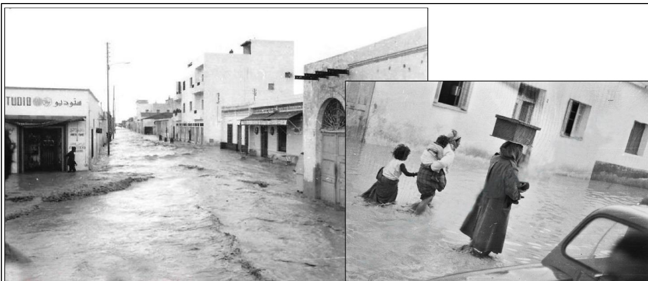
Photo 1. La catastrophe de 1973 : envahissement des eaux de l'oued Medjerda des trottoirs et des voies urbaines (cliché d'un citoyen, 28/03/1973).
