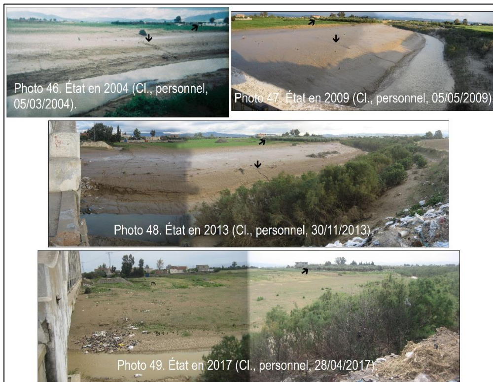
Fig. 78. Vision diachronique (2004-2017) de la progression des atterrissements sur la rive droite de l'oued Mellègue, au droit de son pont « Cinq dinars » à Jendouba (les flèches permettent de reconnaître le lieu).
