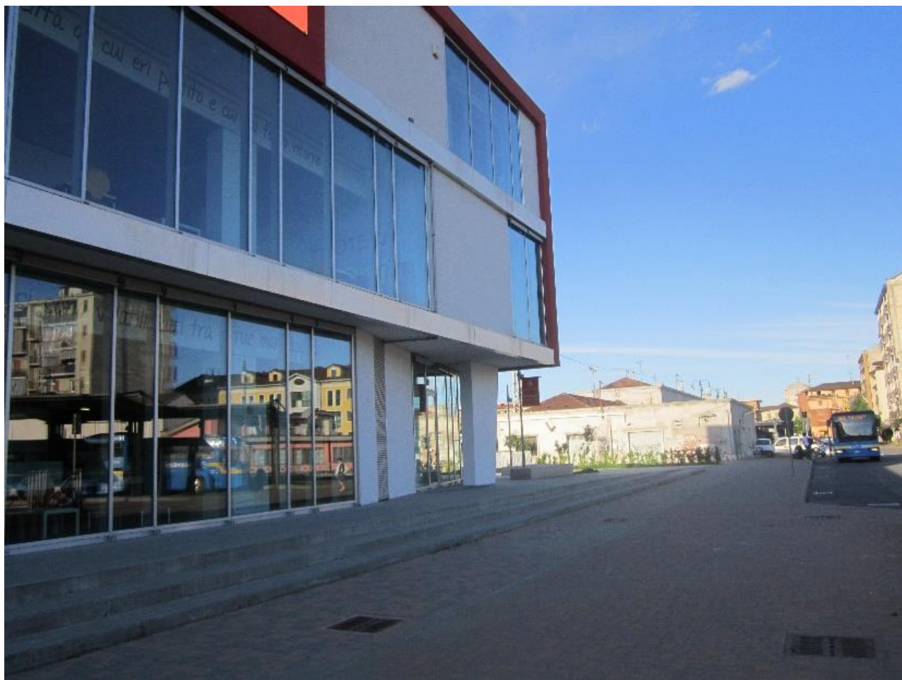
Esterno della biblioteca. In fondo alla fotografia: la stazione ferroviaria di Chivasso
