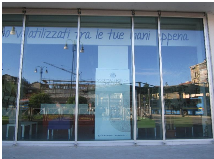
Grande vetrata del piano terra della Biblioteca fotografata dall'esterno
