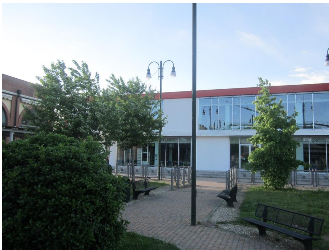
La Biblioteca MOviMEnte. Lato verso il giardino
