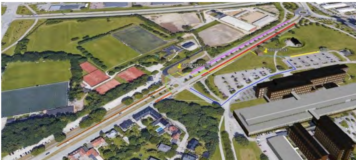
Figure 25 : Implantation de l'infrastructure sur une voie réservée aux bus en proche périphérie de la ville de Lund. Source : Présentation en vue de contribuer à la troisième conférence des systèmes de routes électriques (ERS) à Frankfort en mai 2019, http://media.electricroads.org/2019/04/IS3 - Zethraeus - ELONROAD - A charging infrastructure for cities.pdf , vérifiée le 12/12/2020
