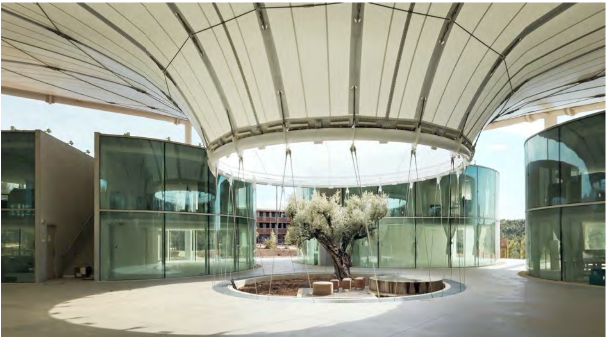
Figure 27 : Espace central abrité et salles de travail circulaires.
