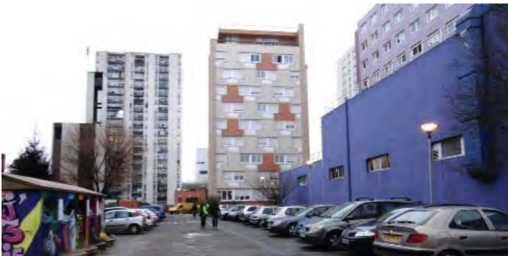
Figure 13 : Vue de la cour de l'association.
