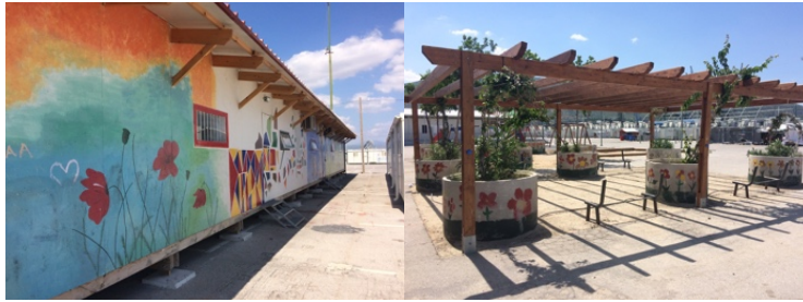
Figure 31 : Le complexe Drop in the Ocean dans le camp de Skaramangas. Grèce, 2019 (Crédits : Idrac)
