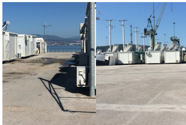
Figure 43 : Containers et artères du RAC de Skaramangas. Grèce, 2017 et 2018 (Crédits : Idrac)
