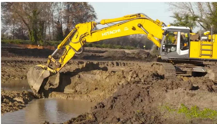
Fig 15. Opération de reméandrage de la rivière par la pelle mécanique (Source : EPTB Vistre)
