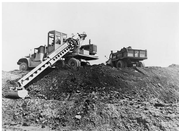
Fig 56. L'Histoire des carrières est corrélée à celle des techniques d'extraction. Ici une pelle excavatrice « Gradall » à la fin des années 1940 (Source : Gradall).
