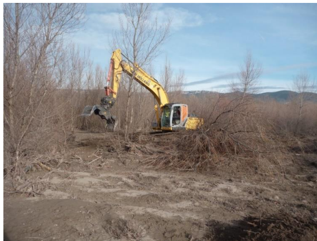
Fig 25. Opération d'essartement dans le lit de la Durance (Source : SMAVD).
