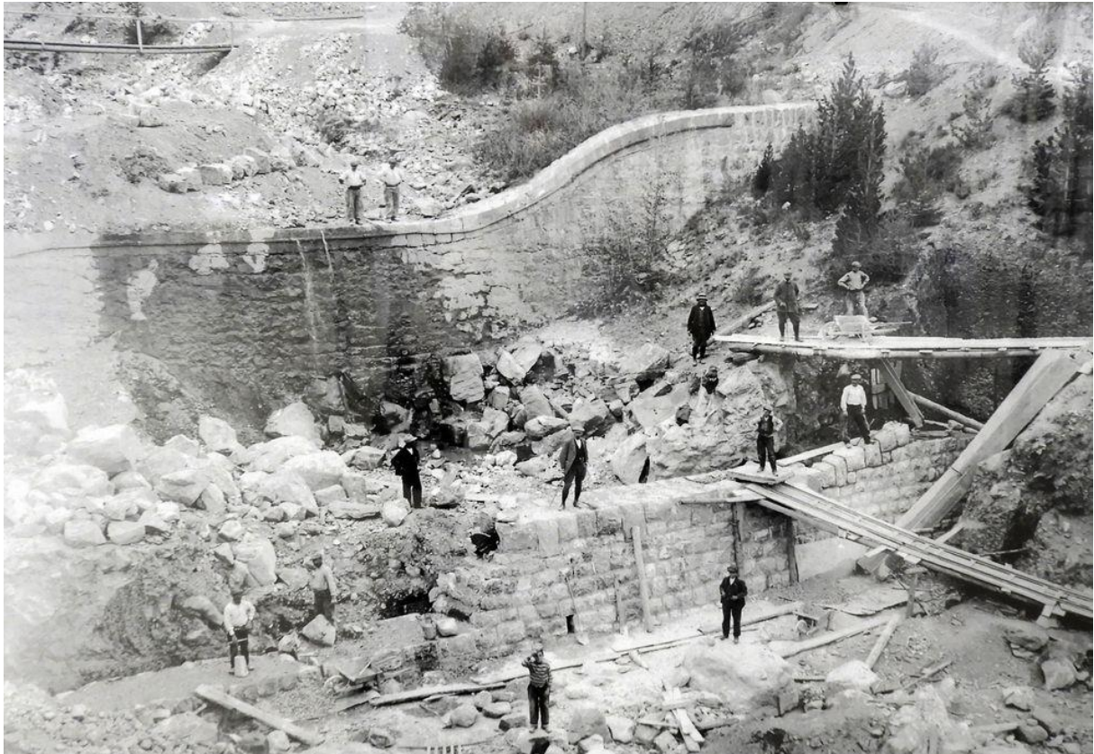
Fig 60. Intervention du service de « Restauration des Terrains en Montagne » en 1913. Alliance des techniques forestières de reboisement et des techniques en génie civil de piégeage des graviers. (Source : RTM)
