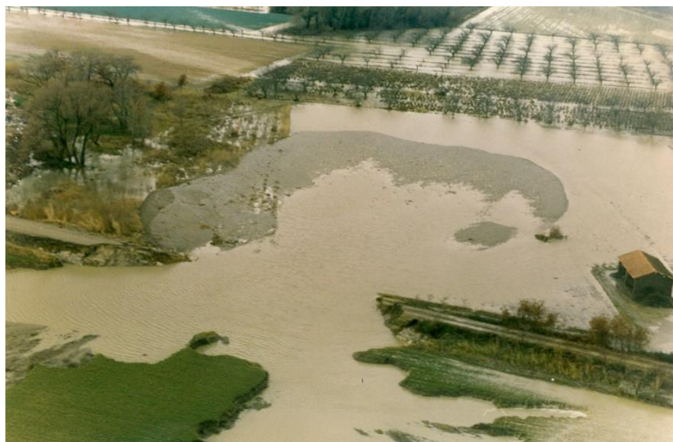
Fig 29. Brèche de l'épi de Basse-plaine (source : SMAVD 1994).
