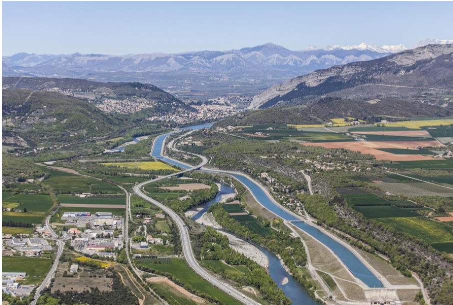
Fig 24. Vue aérienne de la Durance corsetée entre l'Autoroute et le canal de dérivation. (Source : photo aérienne de France)
