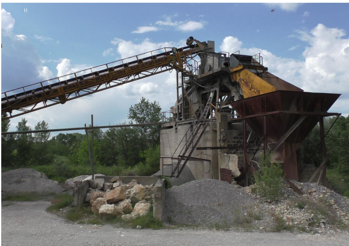
Fig 57. Traces laissées par les chenilles des pelleteuses au pont de Massane en 1961 (ci-dessus ; source : Rapport BURGEAP). Photographie d'un excavateur prise à la sablière « Cévenn'Agrégat » à Cassagnoles (ci-dessous, source : Marie Lussion).
