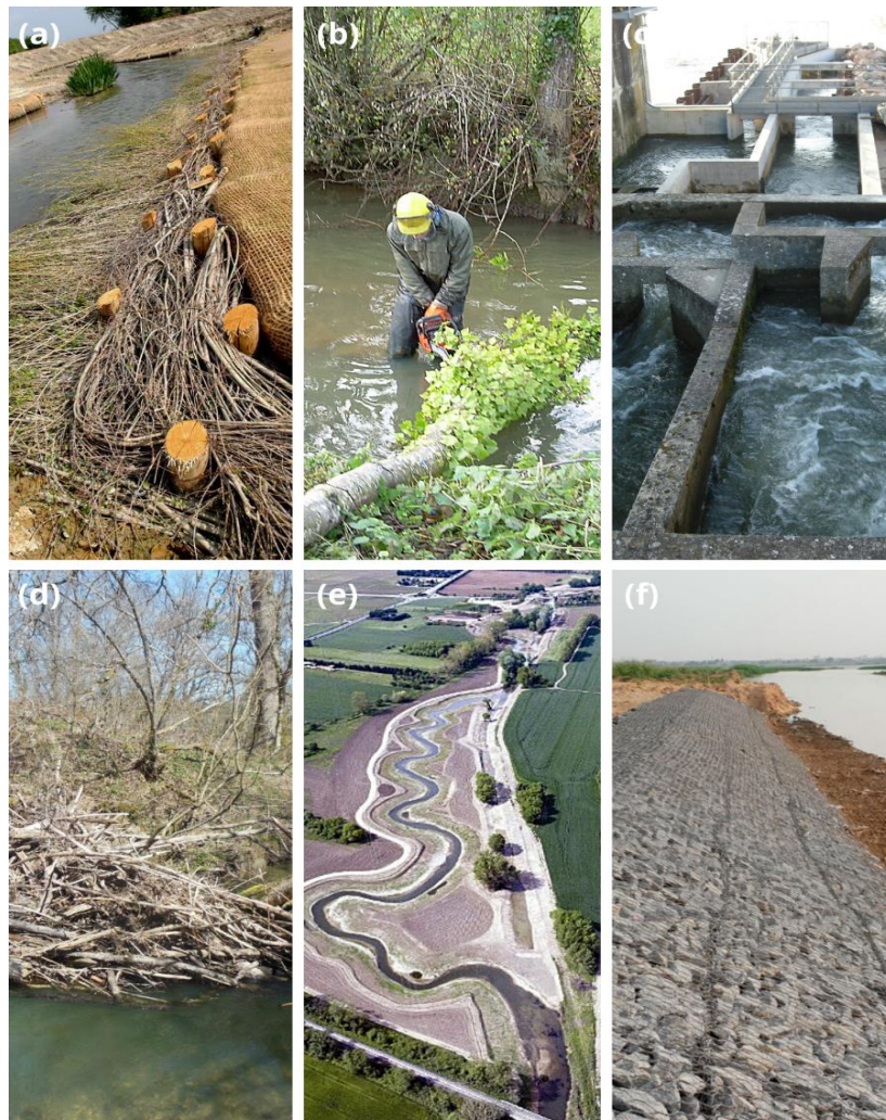
Fig 13. Interventions déclarées « restauration de cours d'eau » : opération sur la morphologie des berges (a), entretien de la ripisylve (b), installation de passes-à-poissons (c), gestion des embâcles (d), opération de reméandrage (e), protection des berges (f).
