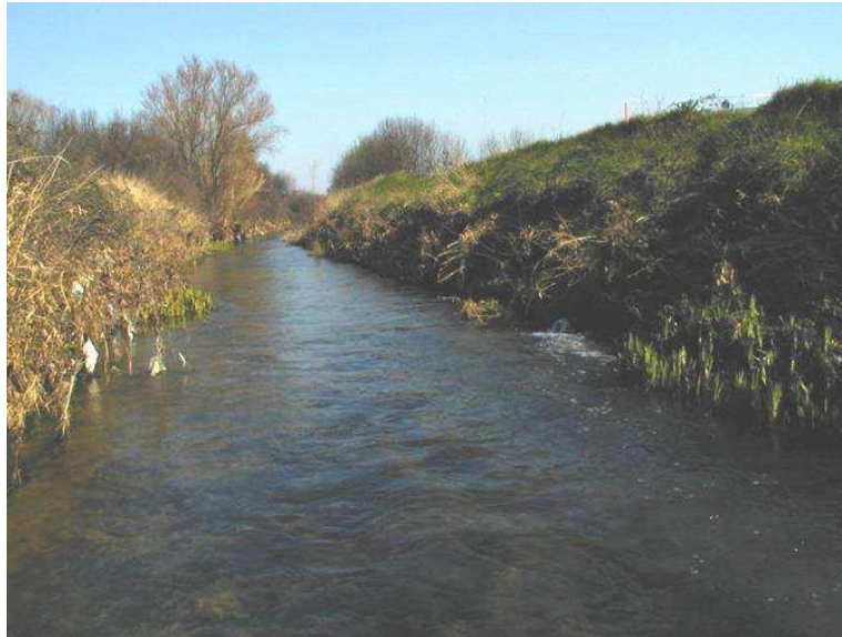
Fig 42. Le Vistre rectifié. Photographie de 2005 (Source : EPTB Vistre).
