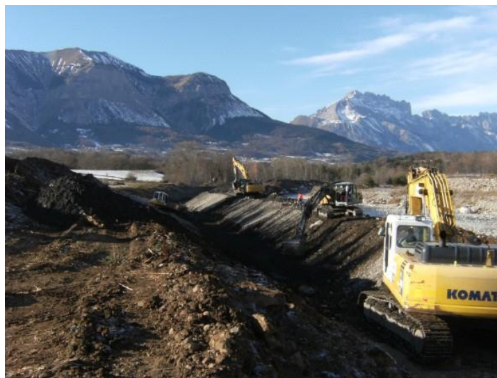
Fig 70. Réalisation des travaux sur le chantier de restauration (source : CLEDA).
