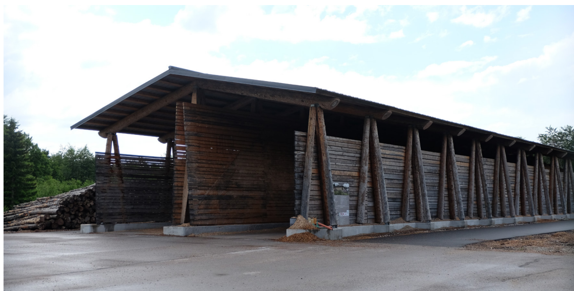
FIGURE 34. La plateforme de stockage de La Mouille en mai 2018.
