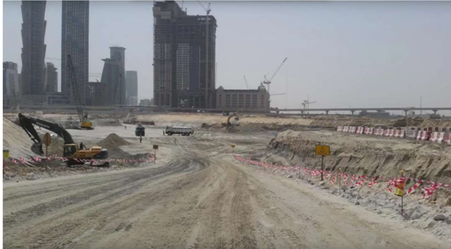
Figure 110 : Les travaux du grand canal.
