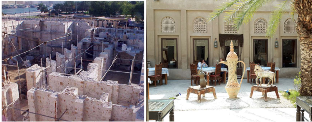
Figure 127 : La réhabilitation d'une maison à tour à vent à Bastakiya.
