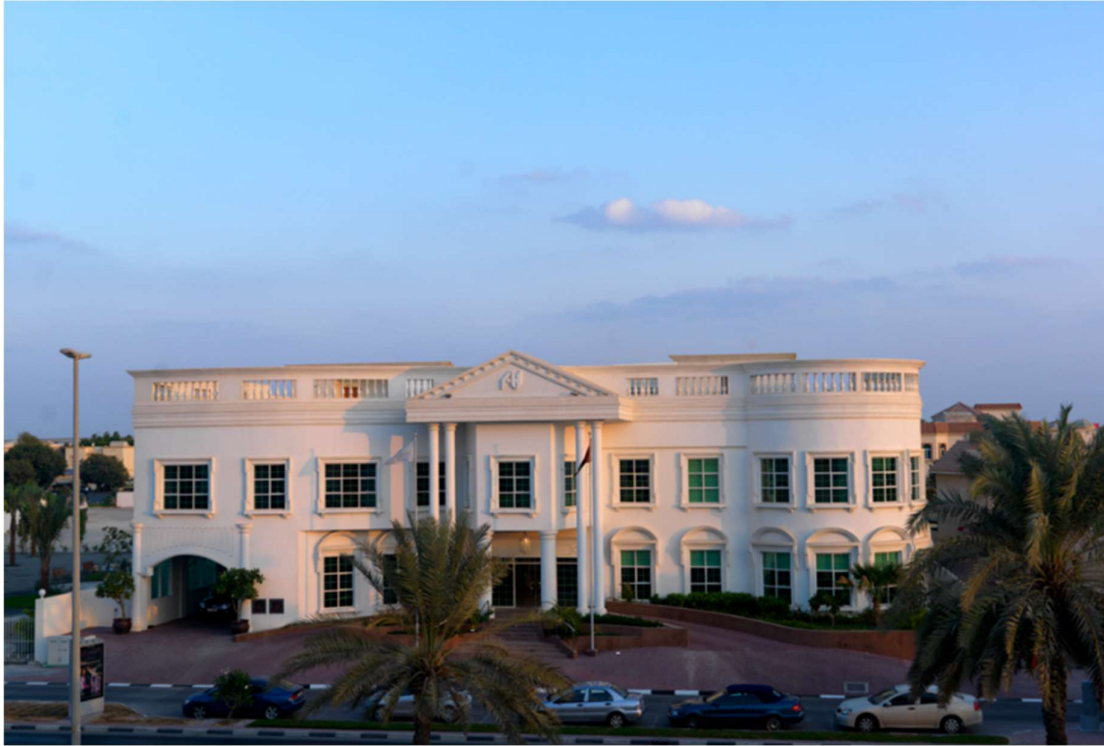
Figure 57 : Le bureau du groupe Al-Habtoor à Al-Safa 2
