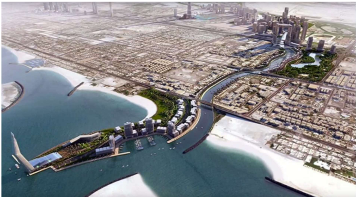
Figure 109 : Le mega-projet du grand canal.
