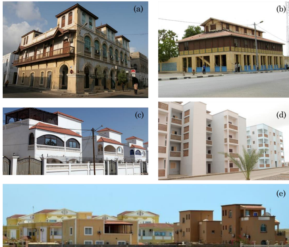
Fig.1. 3 (a-b) Exemples d'architecture coloniale, (c-d) exemples de bâtiments contemporains.
