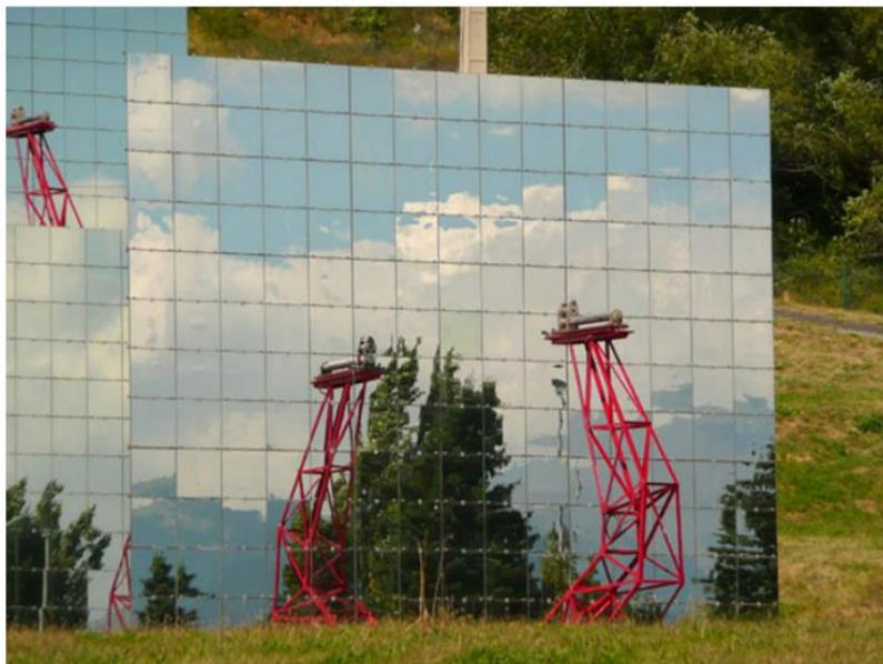
FIGURE I-12: Issue de [53] : Héliostat du Grand Four Solaire
