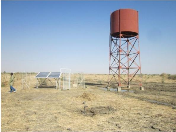
Panneaux solaires et châteaux d'eau sont utilisés pour pomper l'eau de la nappe phréatique et la stocker pour l'arrosage des plants produits sur place au sein de deux pépinières.
