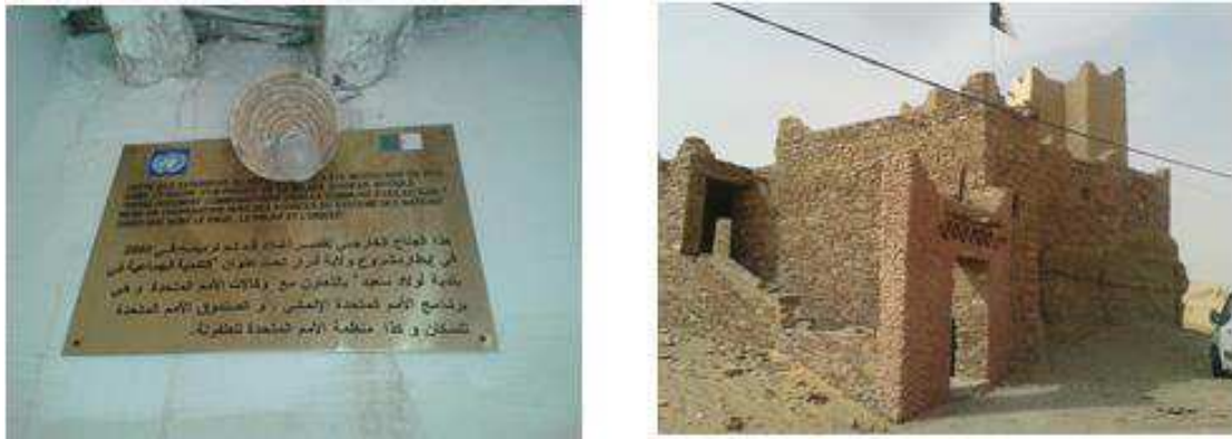
Figure I. 13 : Aghem en pierre d'Aghlad après réhabilitation
