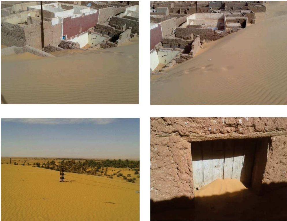
Figure II. 12: Ksour désertés à Timimoun en raison de l'ensablement
