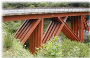
(d) Pont de Merle - pont à béquilles (1999, Corrèze)
