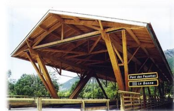
(f) Pont des Fayettez - Pont à poutres latérales en treillis (2000, Isère)
