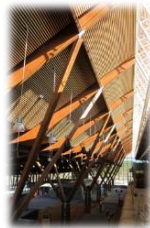
(b) Modernisation de l'aéroport principal de Mayotte (2014, Mayotte)
