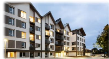
(c) Bâtiment grande hauteur en bois massif (140 logements sur 4 étages) (2017, Ris-Orangis)
