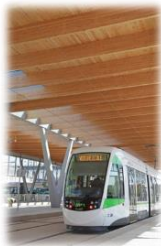
(a) Ajout d'un auvent au pôle Haluchère pour améliorer le confort des usagers du train et du tramway (2011, Nantes)
