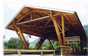
(f) Pont des Fayettees - Pont à poutres latérales en treillis (2000, Isère)
