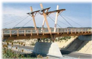
(e) Pont d'Avoudrey – Pont à haubanage et suspension (2005, Doubs)
