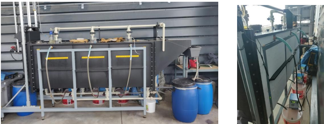
Figure 2-7 (a) Emplacement de l'unité extérieure du laboratoire UniLaSalle (b) Système de chauffage et isolation
